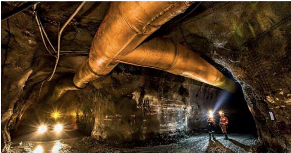
Figura 1.6: Conductos de ventilación. Fuente:[25]
