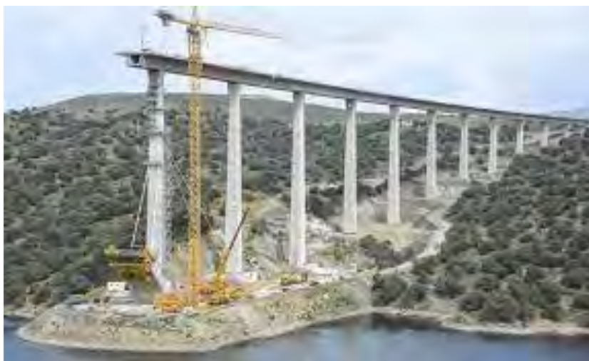
Fig. 2.65 Hormigones de alta resistencia.
