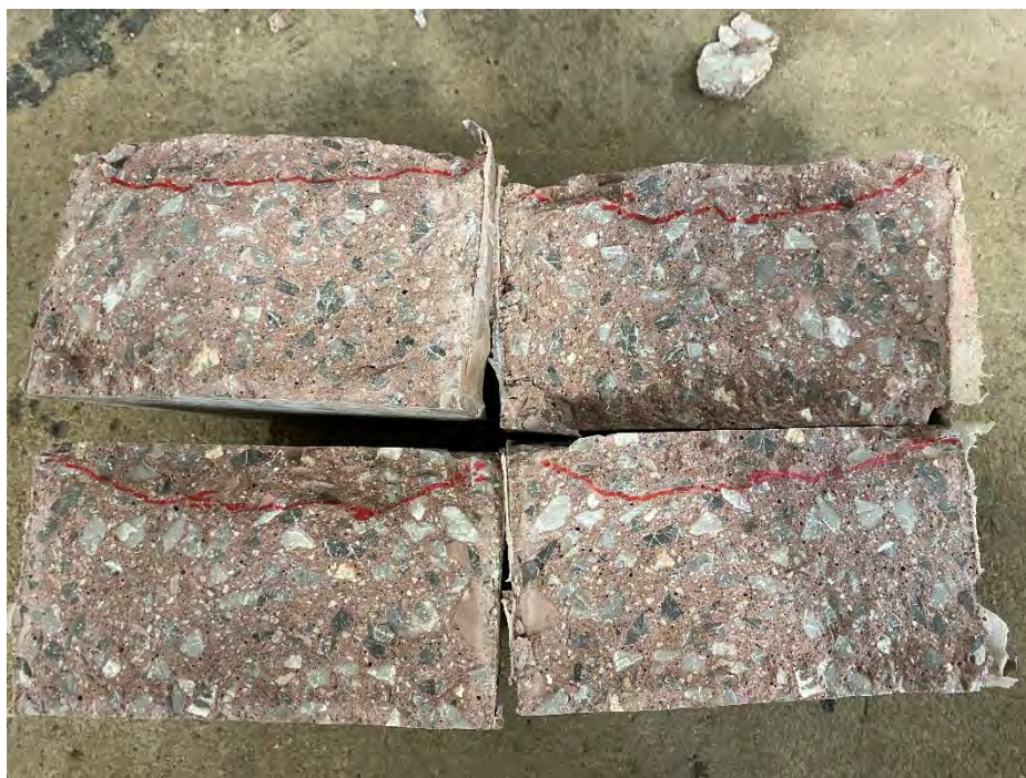
Fig. 4.73. Huellas de penetración máxima en HAC-R100B.
