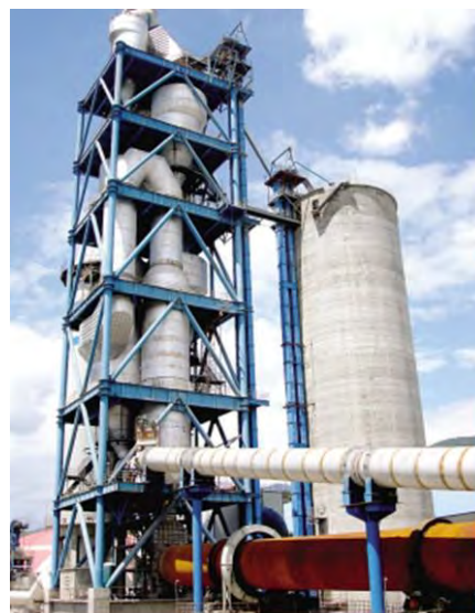
Fig. 2.33. Precalentador ciclones instalado en Cementos Alfa (Mataporquera).
