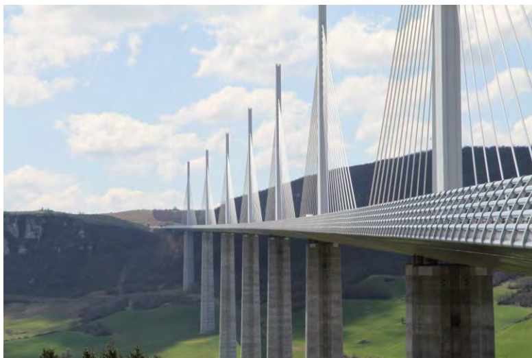
Fig. 2.27 Viaducto de Millau ( www.mexicorutamagica.com.mx ).
