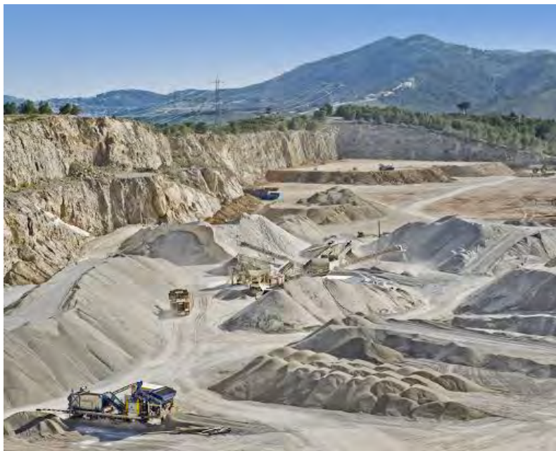
Fig. 2.38 Explotación de cantera de Cementos Portland Valderribas.
