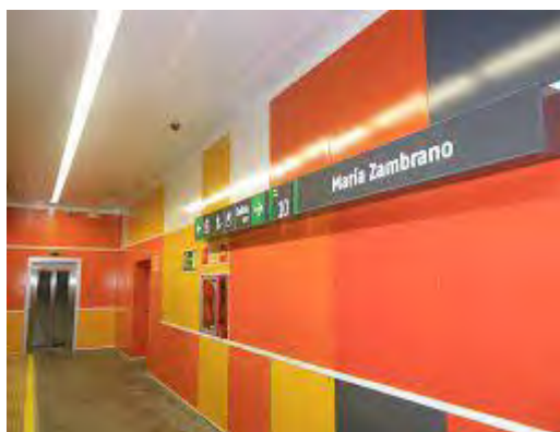
Fig. 2.2. Paneles estación de ferrocarril
