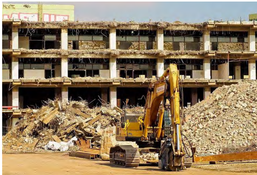
Fig.2.70 Residuos de construcción y demolición. (Transanc).
