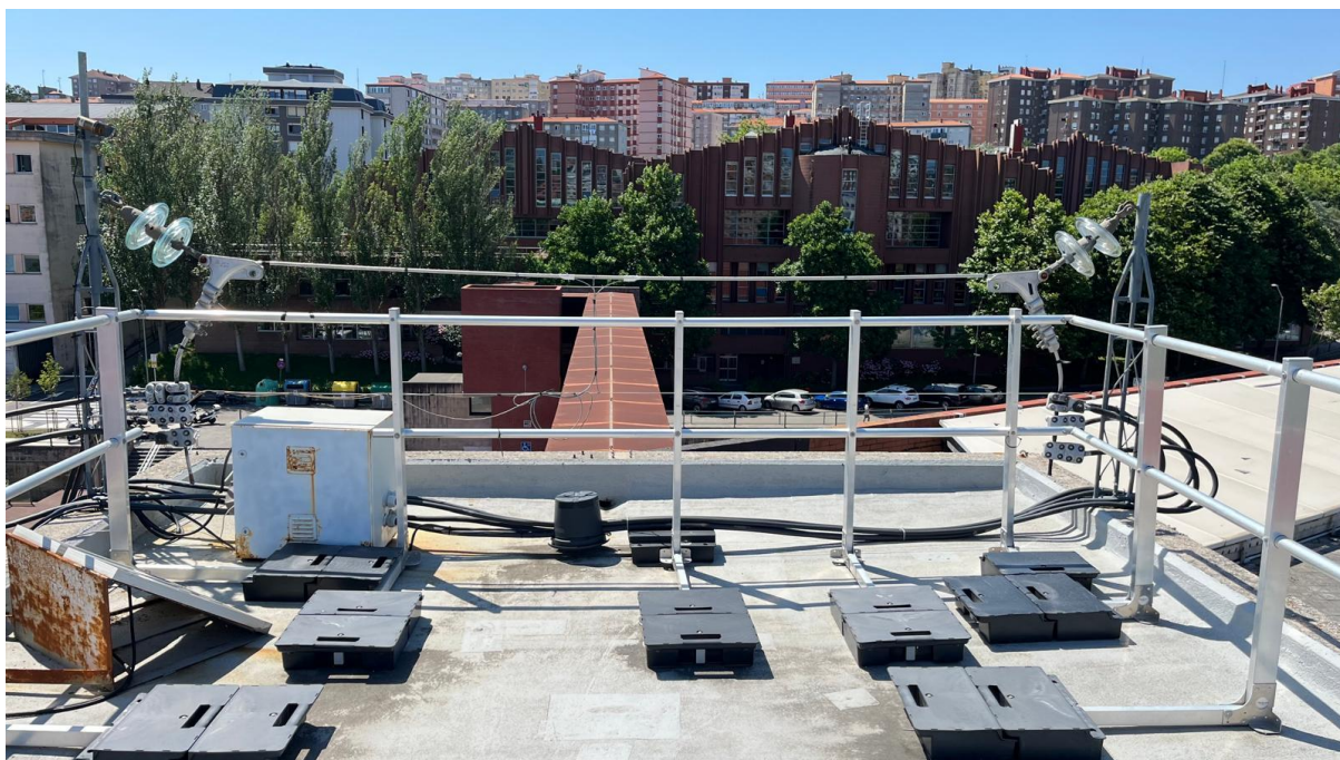
Figura 6: Línea de prueba vista a la misma altura
