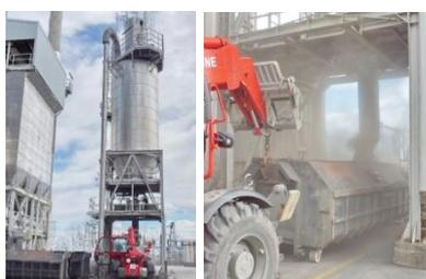
Figura 7: Silo de cenizas y recogida posterior. Fuente: Elaboración propia, marzo 2025
