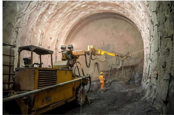
ILUSTRACIÓN 48. HORMIGÓN PROYECTADO EN MINERÍA SUBTERRÁNEA. (FUENTE: HORMIGÓN AL DÍA, 2023)
