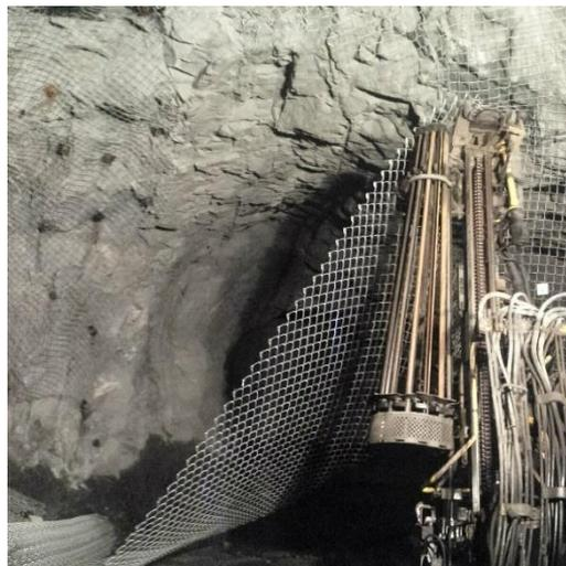
ILUSTRACIÓN 47. MALLA DE FORTIFICACIÓN MINERA INCHALAM. (FUENTE: PRODALAM, 2023)
