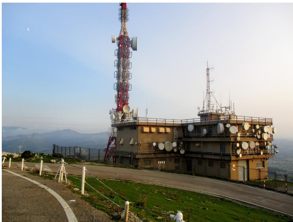
Figura 14. Torre de comunicaciones Peña Cabarga. Fuente: Google Maps.
