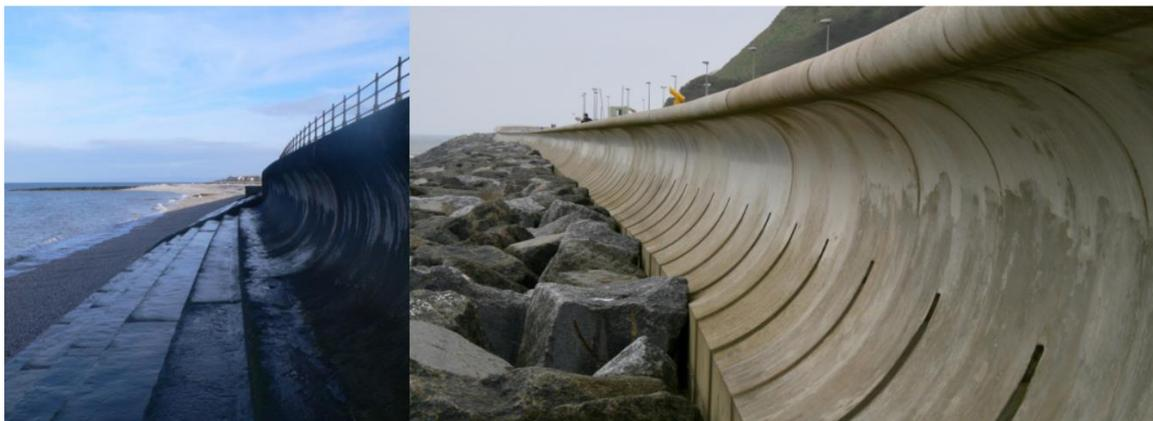
*Ilustración 1-24. Muro de retorno de olas ubicado en Penrhyn Bay, Gran Bretaña, reportado en el panel izquierdo. Muro de contención recurvado con armadura de roca en Scarborough, reportado en el panel derecho. [Fuente: (Myrta Castellin, 2018)]*
