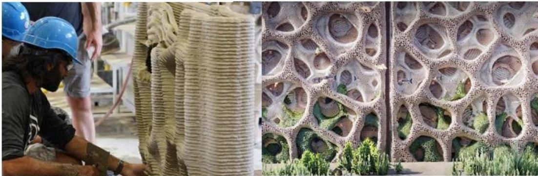
*Ilustración 1-49. Impresión de Muros Vivos con Impresión 3D. [Fuente: (3DNatives, 2024)]*
