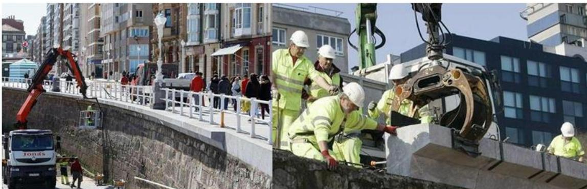
Ilustración 1-21. Instalación de Botaolas en Muro Costero [Fuente: (La Nueva España, 2018)]
