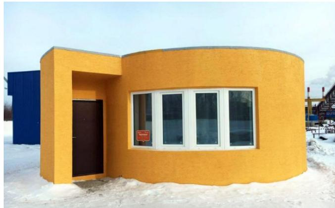
Ilustración 1-40. Vivienda impresa por APIS COR en Moscú. [Fuente: [Fabricadas, 2017](#)]
