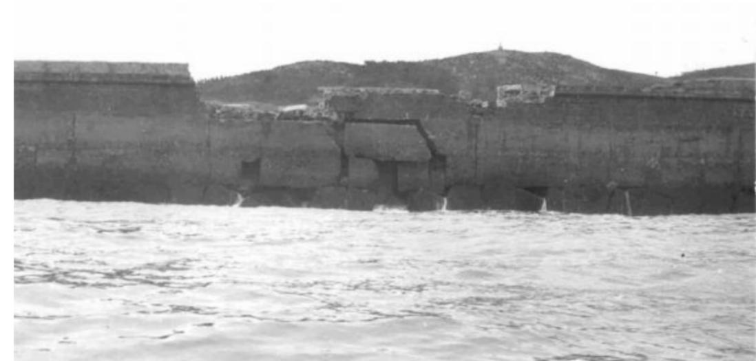
Figura 4. Movimiento de bloques en 5ª y 6ª hilada y rotura de espaldón, 1965.
