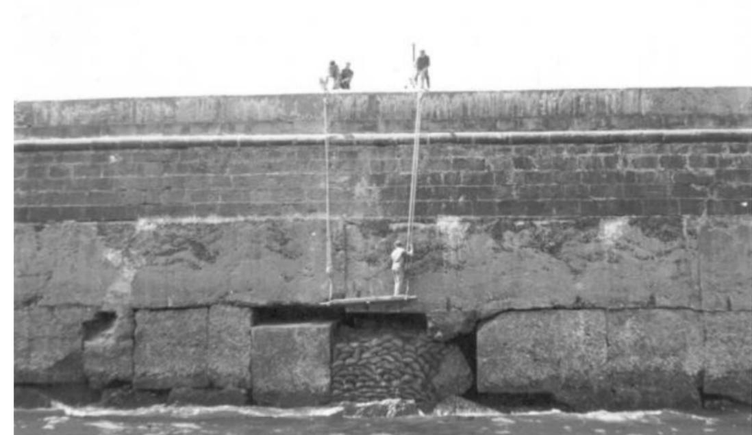
Figura 5. Reparación con sacos de cemento, 1962.
