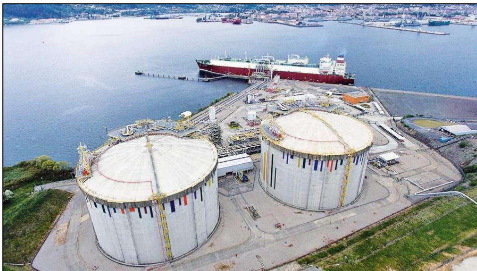
Ilustración 5 - Planta de GNL de Mugardos, en Ferrol. Fuente: El Correo Gallego
