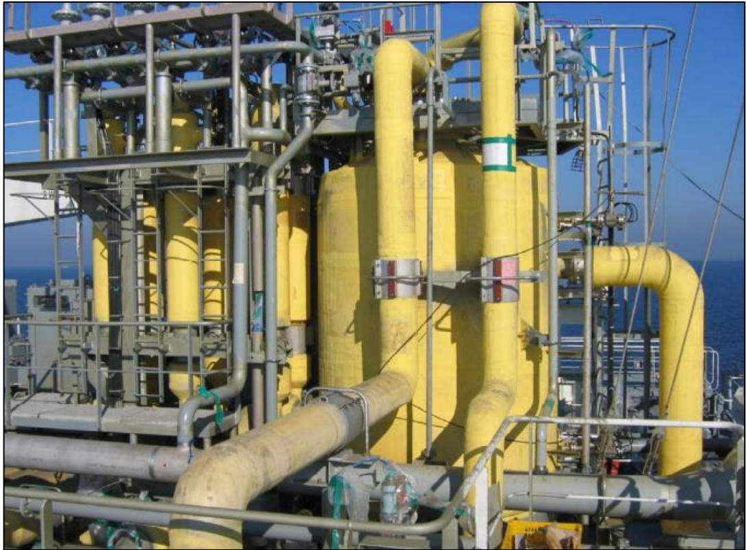
Ilustración 9 - Depósito de succión en un buque FSRU. Fuente: Autor.
