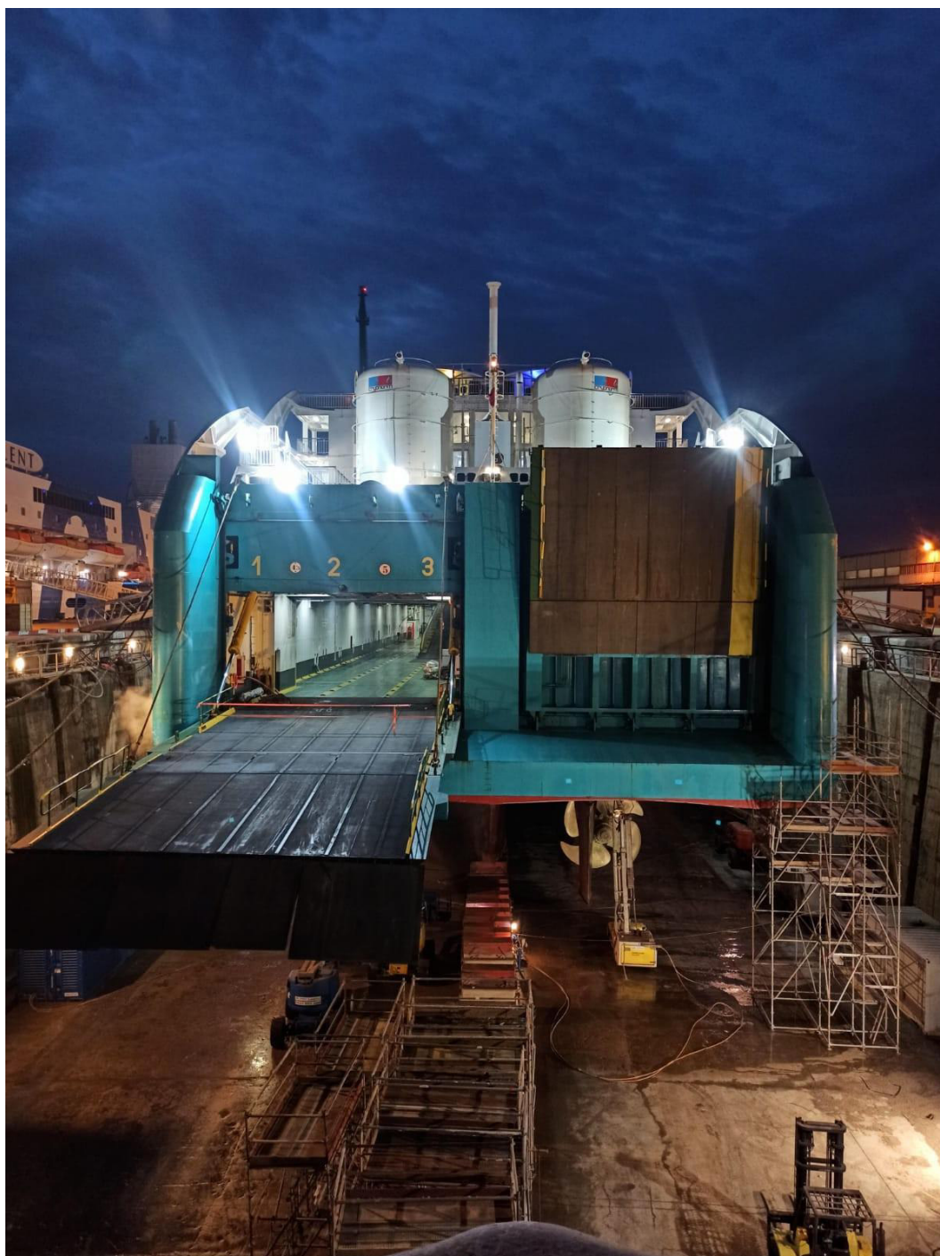
Ilustración 9 Vista de popa con rampa de babor abierta por trabajos en el interior de la bodega. Fotografía tomada por el alumno durante la Varada del S/F Bahama Mama en 2022.
