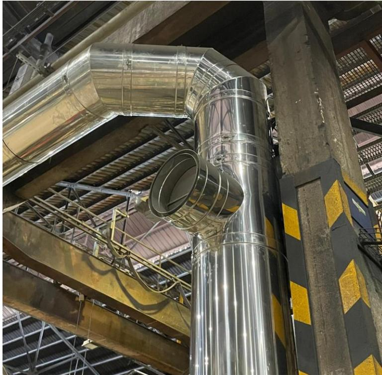
*Ilustración 27: Captación de aire exterior para bajar el nivel térmico del aire caliente.*
