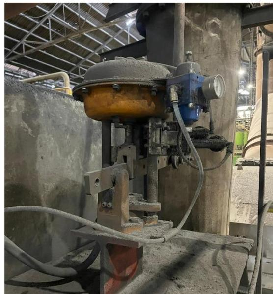
Ilustración 15: Válvula de presión.
