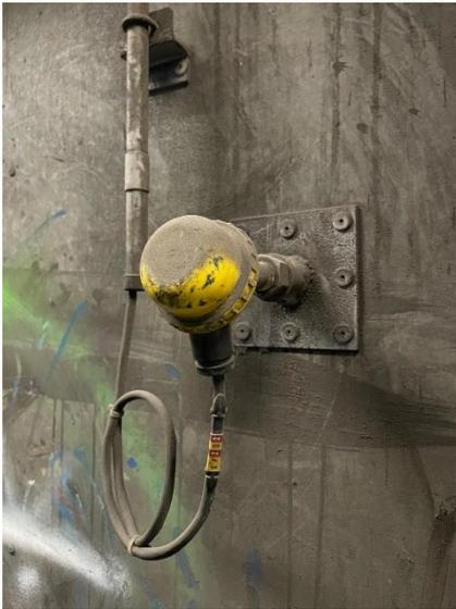
Ilustración 19: Sondas de temperatura.
