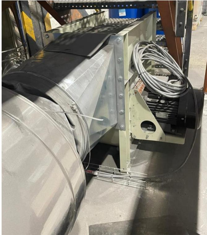
*Ilustración 26: Ventilador de trasiego.*
