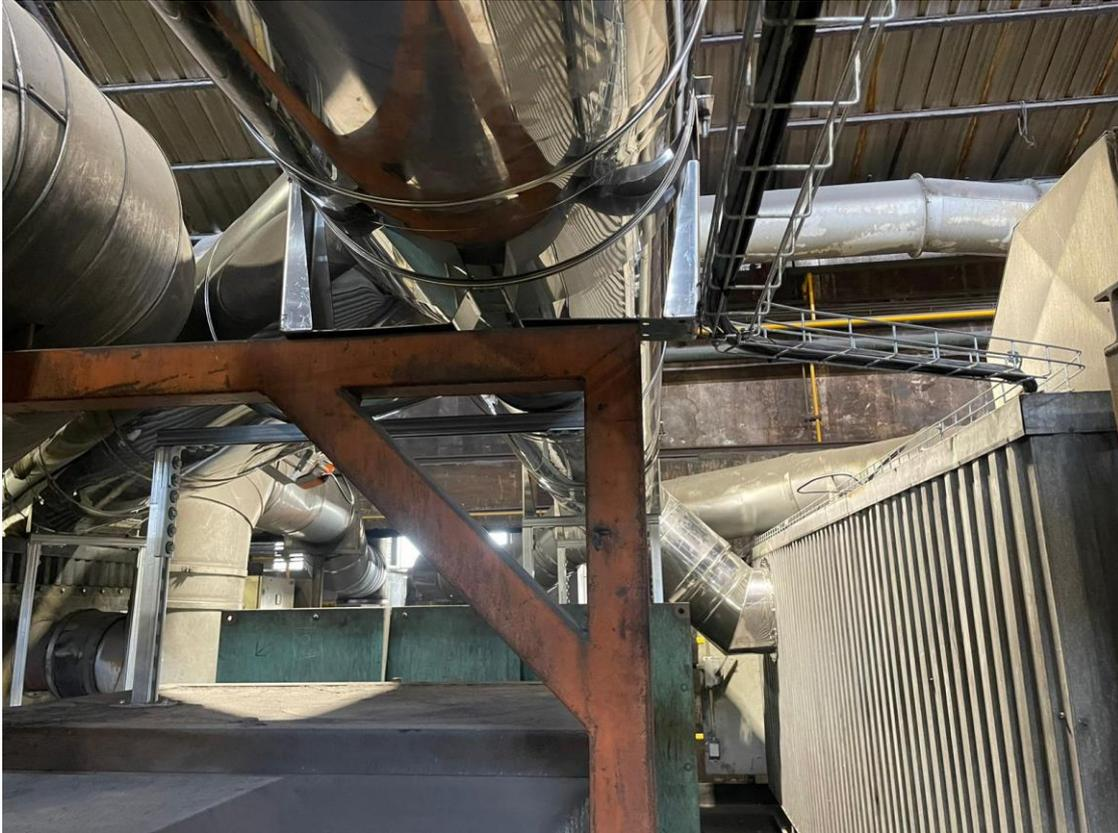
*Ilustración 29: División de la tubería y entrada en las UTAs.*
