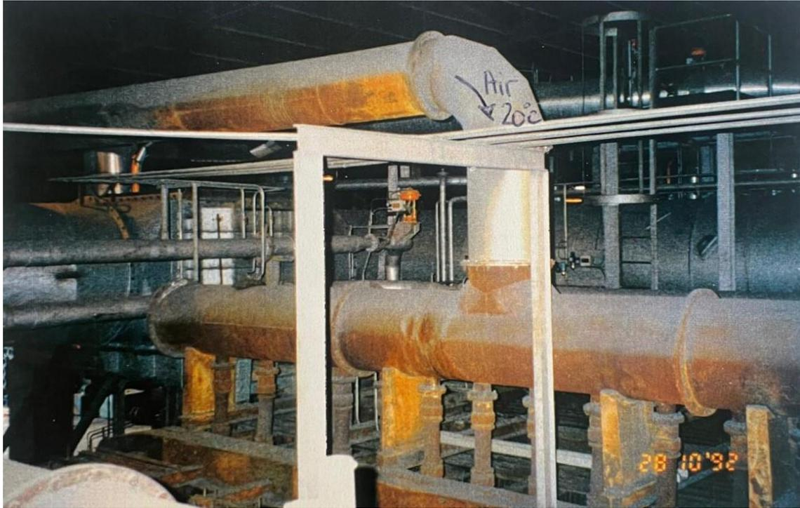
*Ilustración 16: División del colector primario en tubos.*
