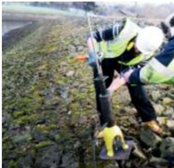
*Figura 21 - Operario instalando sistema de anclaje de banco (9)*
