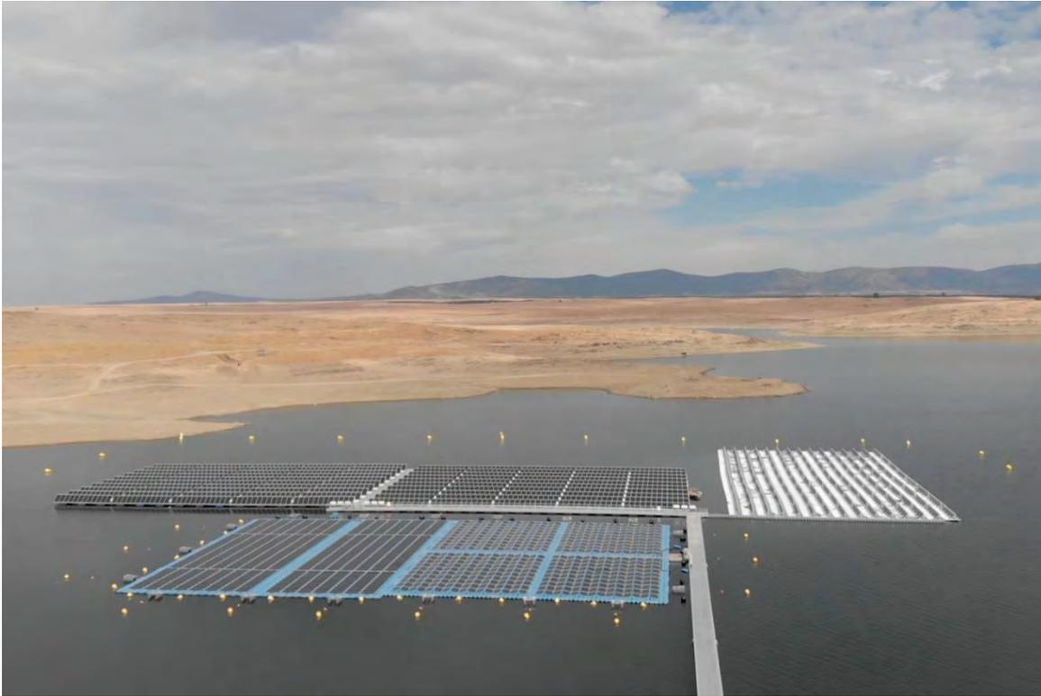
*Figura 3 - Instalación fotovoltaica flotante del embalse de Sierra Brava, Extremadura (6)*
