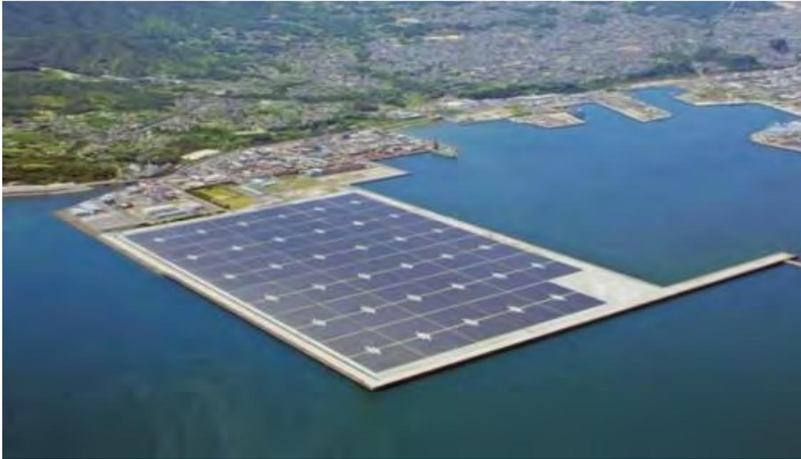
*Figura 1-Instalación fotovoltaica flotante Yamakura, Japón (2)*
