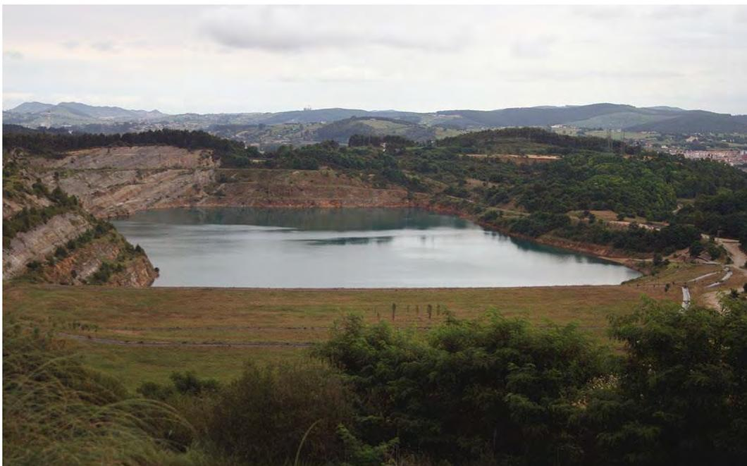
Figura 41 - Lago artificial creado tras la inundación de la corta de la mina de zinc de Reocín (Fotografía: M. Calvo, 2013) (51)
