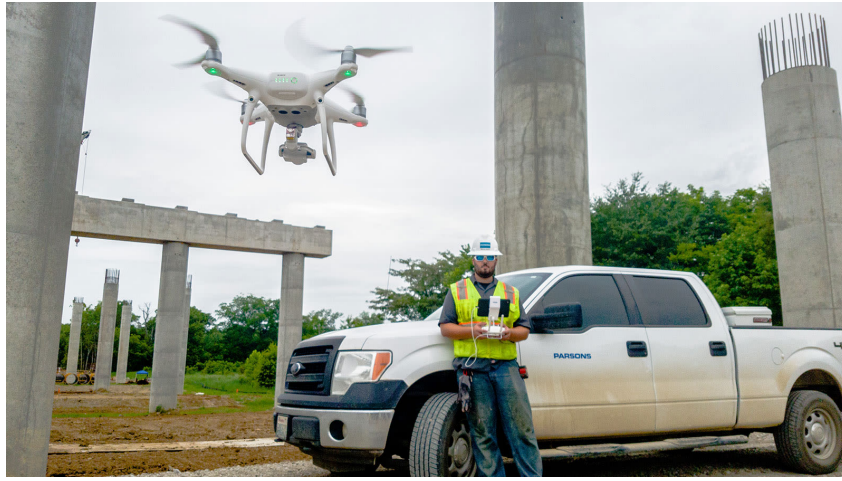
Figura 2.3: Uso de drones y reconstrucción 3D en la construcción
