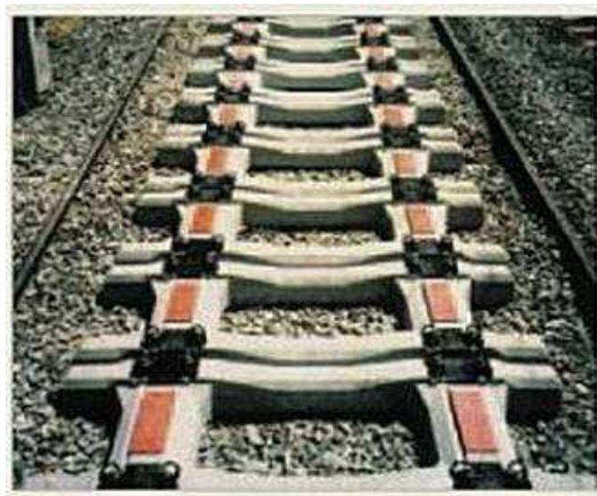
Figura 28 Traviesas cuadro propuestas como solución superestructural de transición de vía en balasto a vía en placa (Admetlla y Lopez Pita, 2010)
