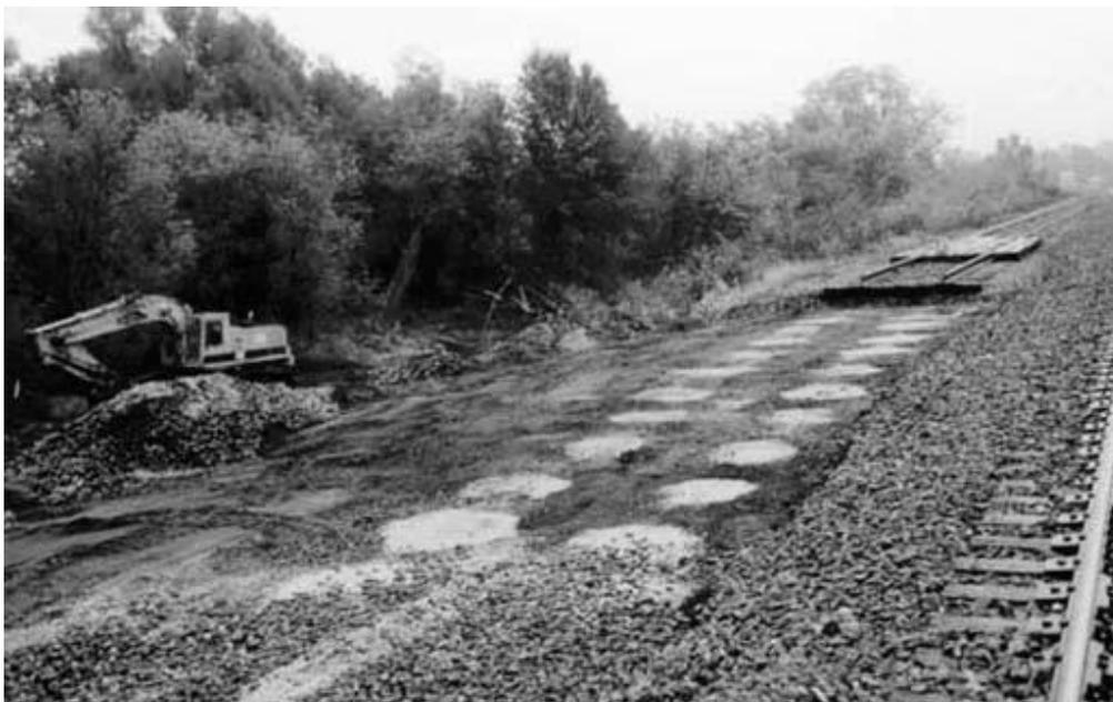
*Figura 7 Refuerzo mediante columnas de grava (Read y Li, 2006)*
