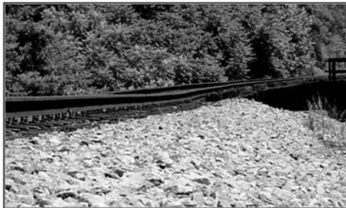
*Figura 1 Deterioro de la geometría de vía en la zona de transición (Read y Li, 1997)*
