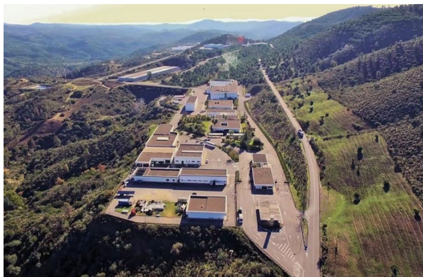
Figura 9: Vista aérea El Cabril. Fuente El Diario de Córdoba.
