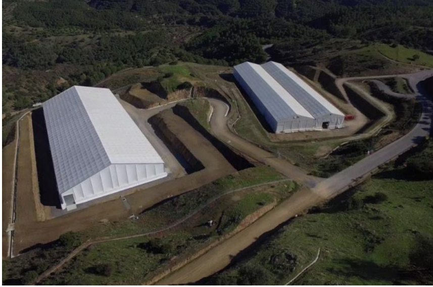
Figura 10: Instalación complementaria para el almacenamiento de RBBA. Fuente The Objective.
