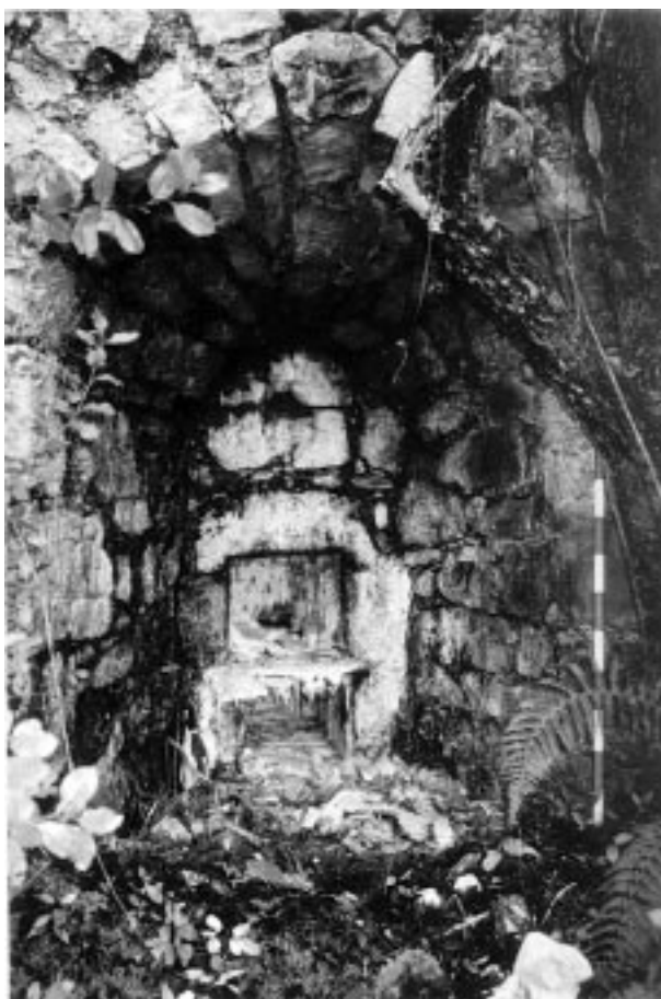
Fig. 5b- Detalle de horno de calcinación
