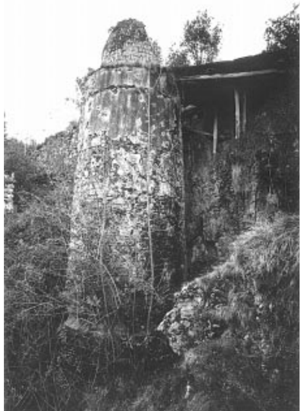
Fig. 7- Horno de transformación de la dolomía en el barrio de Helguera
