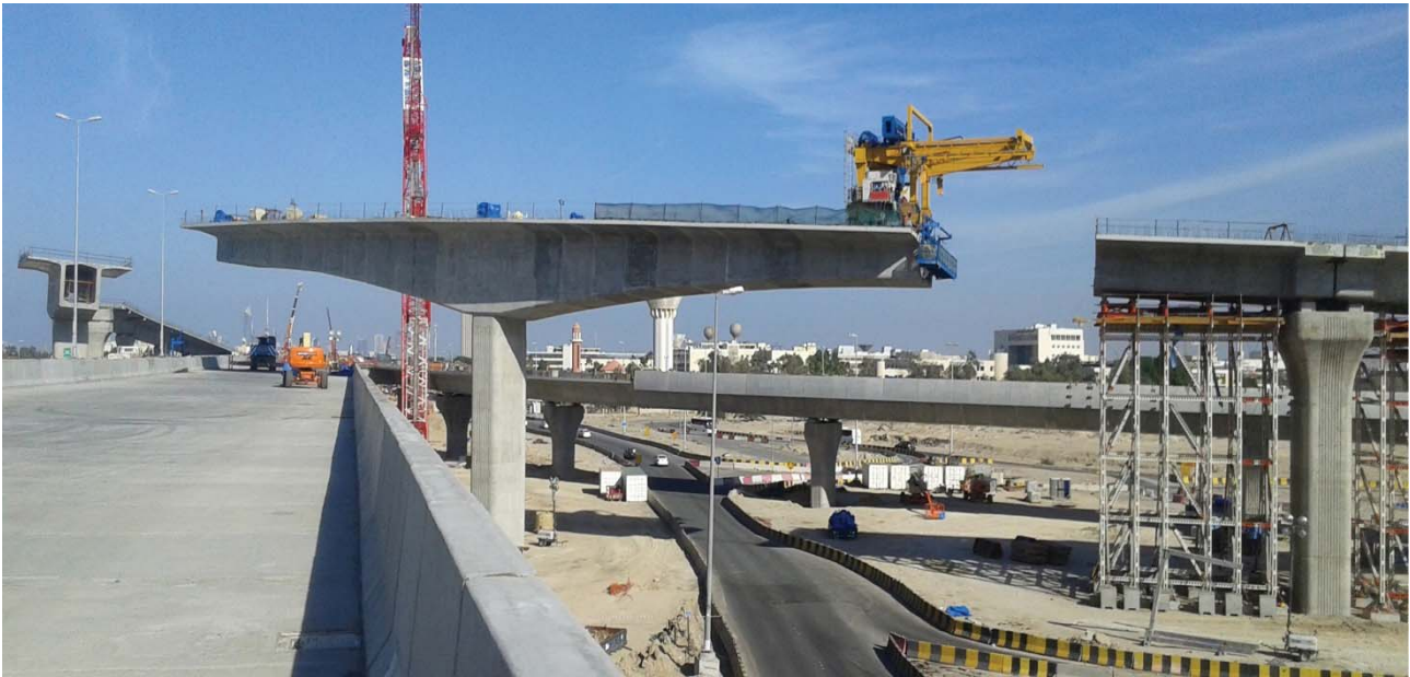
Figura 7. Construcción de una de las rampas por avance en voladizo.
