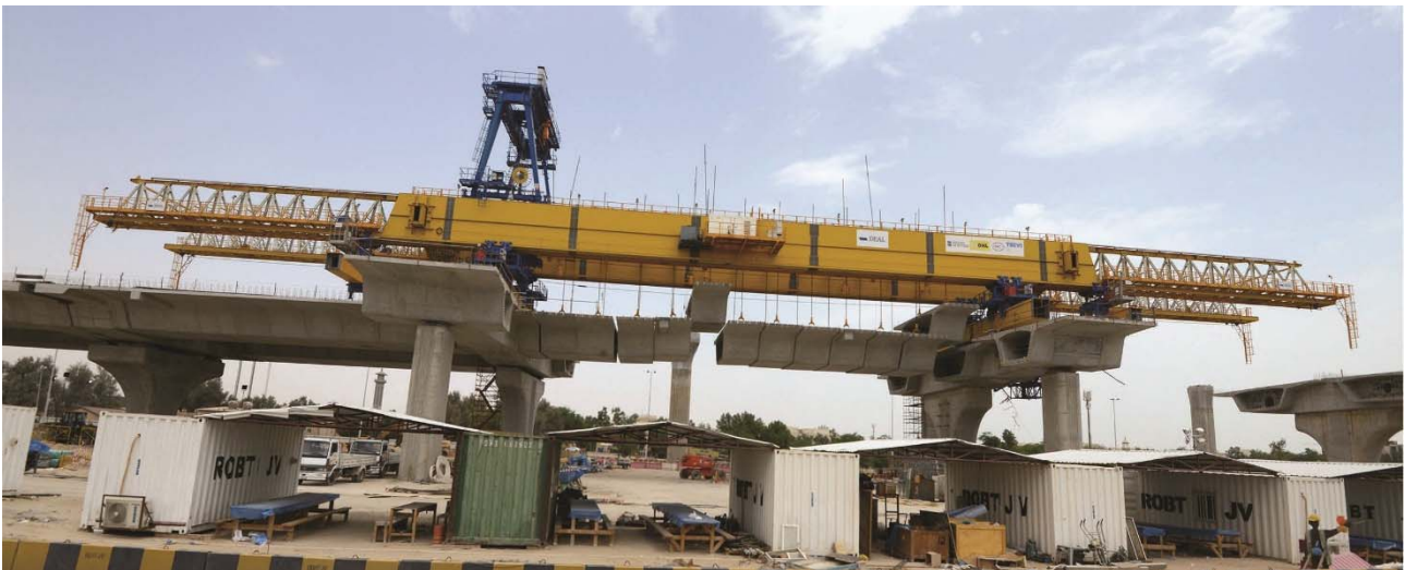
Figura 8. Construcción vano a vano del viaducto principal.
