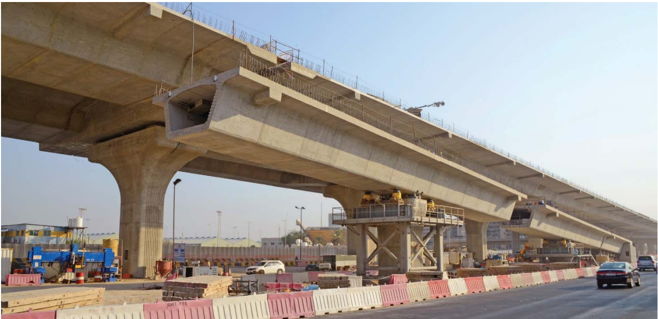
Figura 11. Construcción de la rampa NRM por avance en voladizo.
