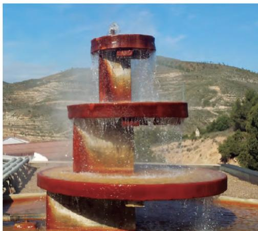
Figura 2: Balneario de Fitero (Navarra). Torre de refrigeración
