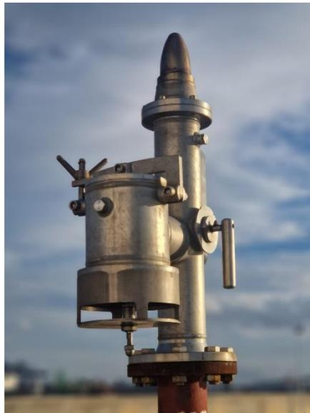
*Ilustración 6 Válvula PV. Fuente: Elaboración propia*
