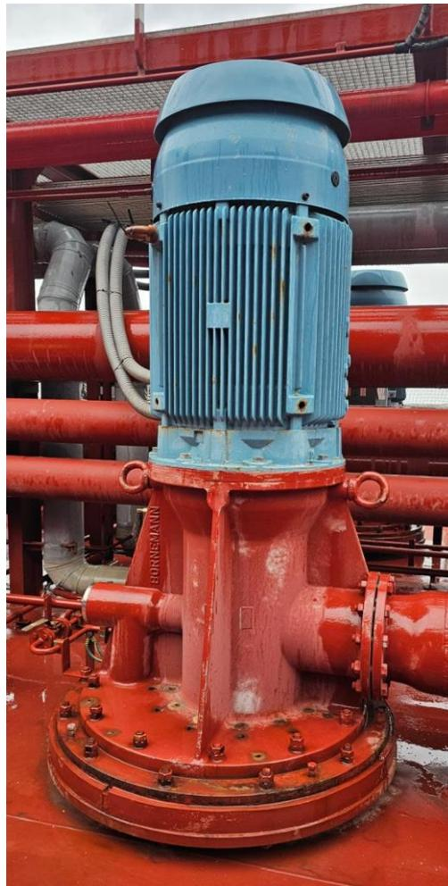
*Ilustración 3: Bomba de Gasoil. Fuente: Elaboración propia.*
