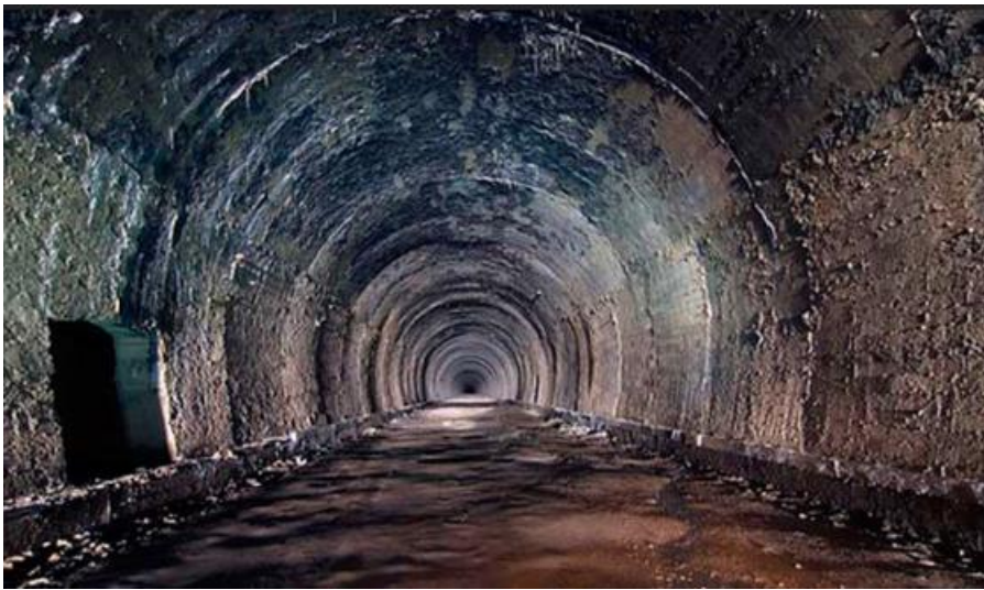
Figura 11: Imagen del túnel de la Engaña
