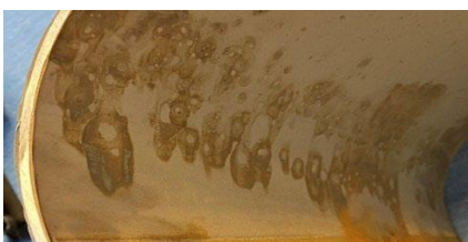
Figura 3. Múltiples inicios de picaduras en interior tubo.
