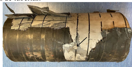
Figura 1. Muestra de tubería extraída del sistema de tuberías del puerto; en el centro se observa una picadura a través de la pared (flecha negra).
