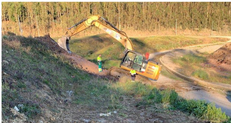
Figura 5-5. Refuerzo de la capa de cobertura del punto alto de la Celda A.
