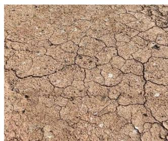
**Figura 5-7. Grietas provocadas por la desecación del material arcilloso usado como cobertura.**
