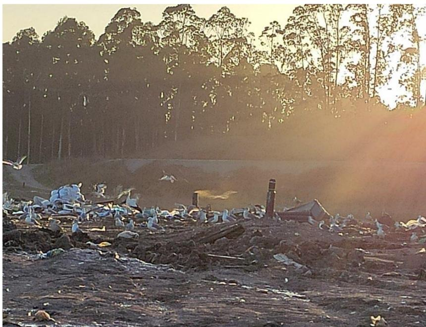
**Figura 5-4. Pluma de gas procedente de una chimenea sin tapar, junto a otra chimenea que permanece tapada.**
