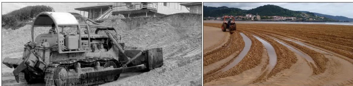
Figura 1 Técnicas de recuperación asistida analizadas en esta tesis. Izquierda: Reperfilado de playas aplicado en Gold Coast 1965 (Australia). Fuente: Carley et al. (2010). Derecha: Arado de playas aplicado en Laida 2015 (España).
