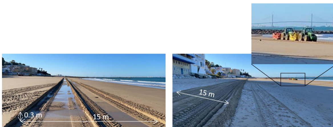
Figura 20 Mototrailas realizando el reperfilado de la playa de Fuentebravía.
