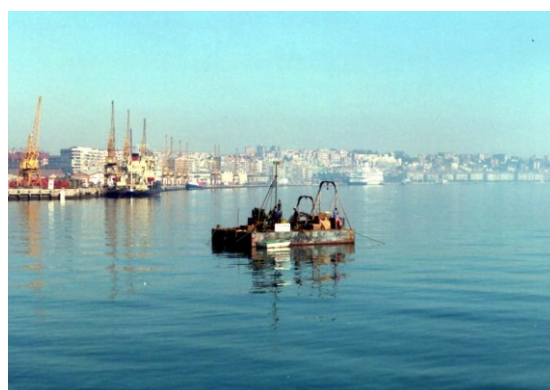
Figura 2.7: Ejecución de sondeos por ICINSA en la Bahía de Santander
