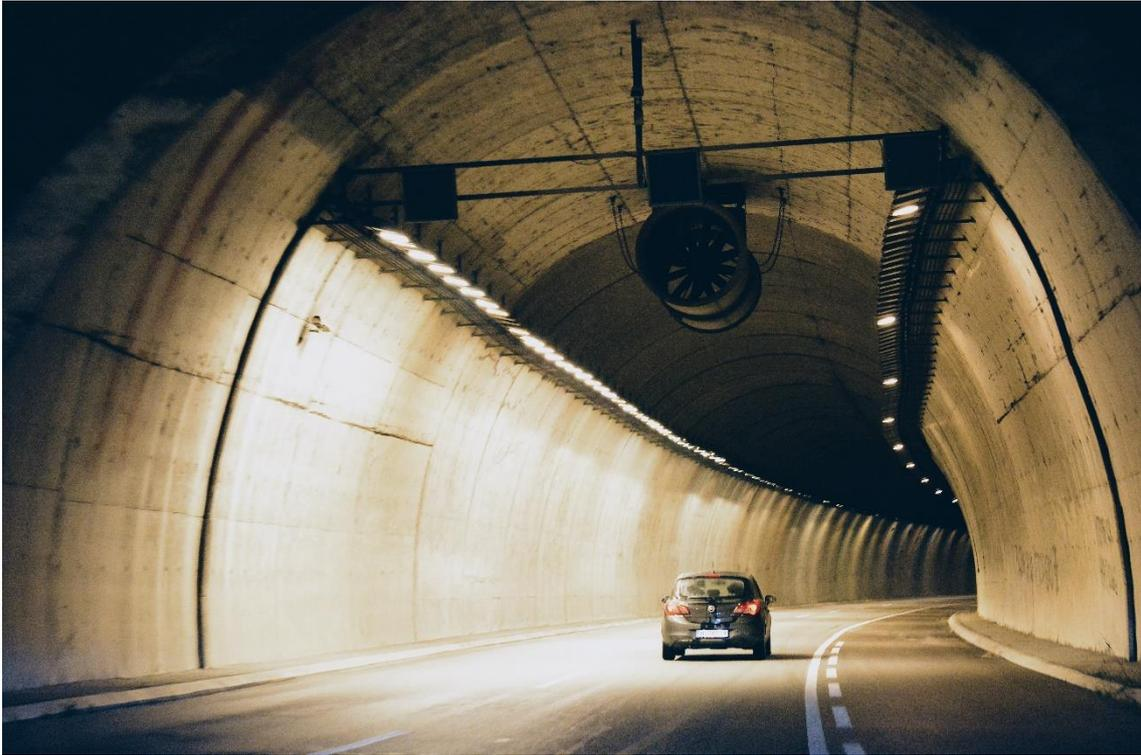
*Ilustración 3.2: Ventilación longitudinal de un túnel durante el período operativo. (Fuente: Pixabay)*
