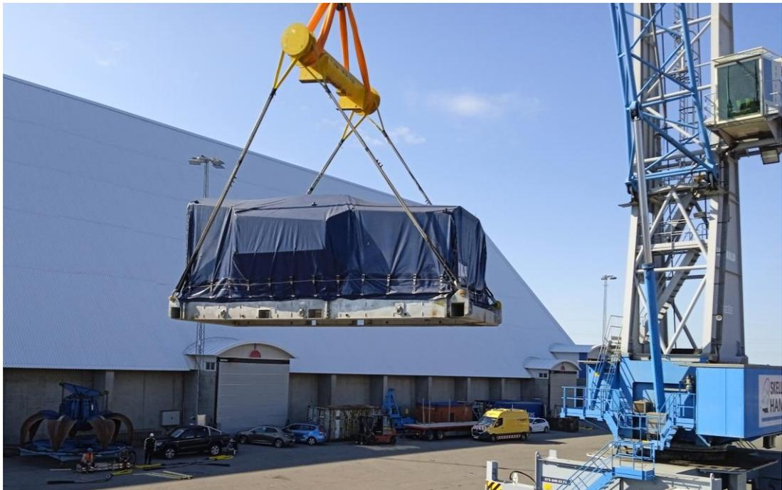
*Ilustración 23 Transmisión izada con el aparejo. Fuente: Autor.*
