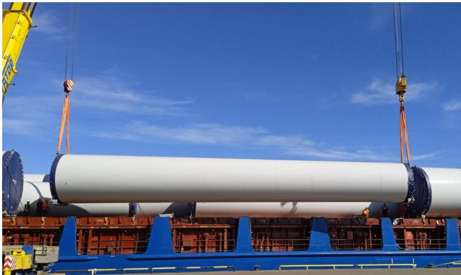
*Ilustración 4 Torre manipulada con eslingas y grilletes. Fuente: Autor.*
