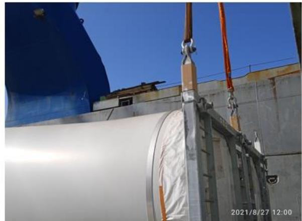
*Ilustración 39 Palas izadas con eslingas. Fuente: Autor.*
