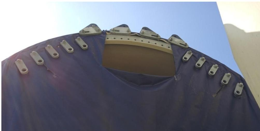
*Ilustración 8 Ventana abierta en la parte superior de la lona. Fuente: Autor.*
