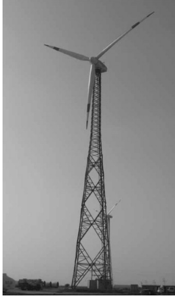
Figura 9: Ejemplo de torre de celosía que sostiene al aerogenerador. Fuente: [23]
