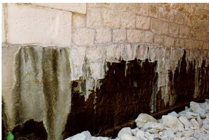
*Ilustración 522. ALT-02 Descripción: Depósitos salinos (Eflorescencias/Concreciones/Incrustaciones/Costras Negras).*
