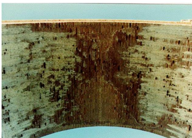
Ilustración 788. FUN-05 Descripción: Manchas de humedad e inadecuado funcionamiento de los mechinales.
