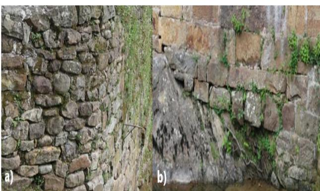
a) Perdida de material de juntas en el estribo en la parte superior
