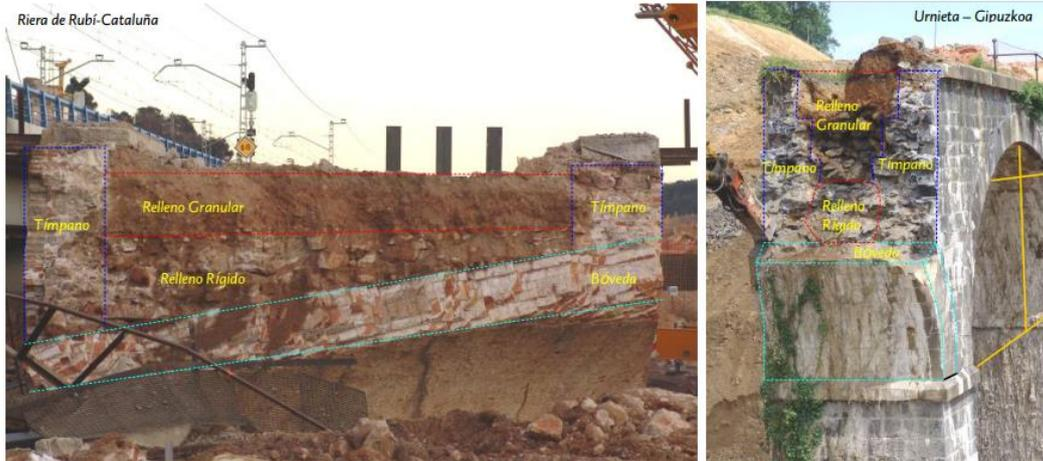
Ilustración 20. Secciones transversales de los puentes de la Riera de Rubí y de Urnieta. Se pueden diferenciar con claridad la bóveda y su aparejo, los tímpanos y su forma, además se comprueba la existencia del relleno rígido y relleno granular.
