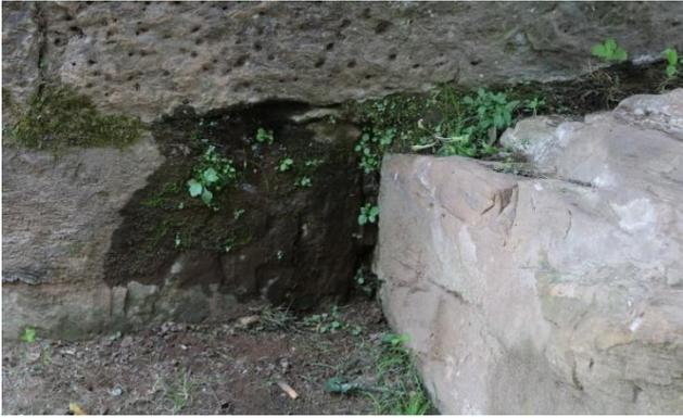
Manchas de humedad o inadecuado funcionamiento de los mechinales en el estribo de la bóveda 2 desde el lado derecho
