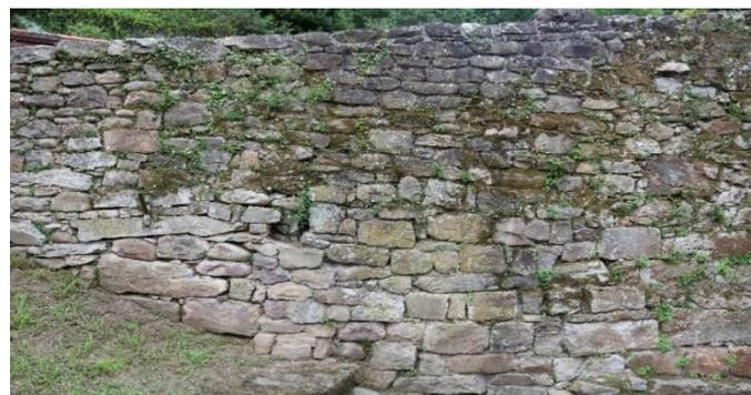
Desagregación en el Muro de acompañamiento de la bóveda 1 desde el lado derecho
