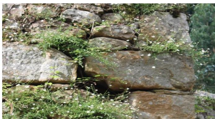
Rotura de aristas y esquinas de sillares en la pila
