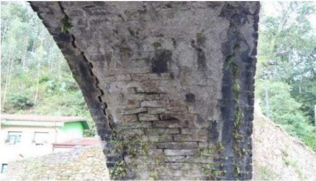
Fisuración o agrietamiento de la bóveda 1 en la unión con la boquilla
