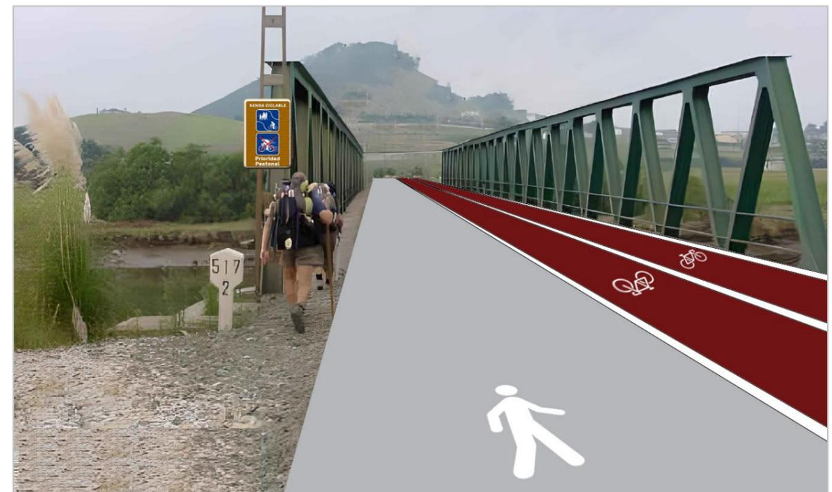
Ilustración 9 - Propuesta de senda ciclable en el antiguo puente sobre el río Pas. Fuente: Autor
