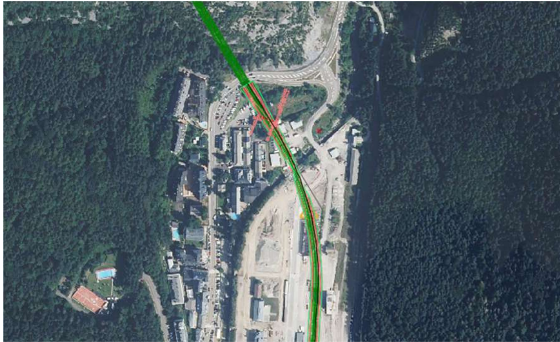
Imagen 3. Detalle del tramo “Canfranc-Túnel del Somport” en su cruce con el río Aragón.
