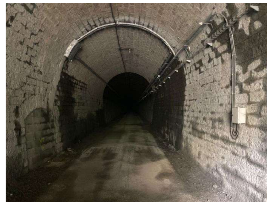
Imagen 4. Sección de túnel en la salida por el lado francés.
