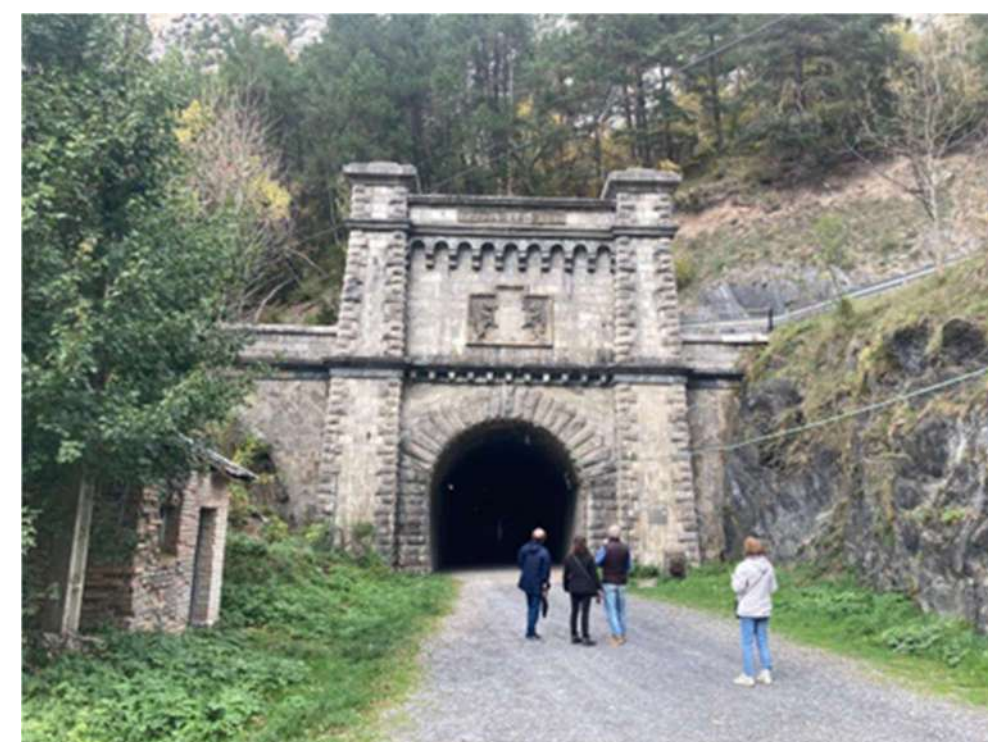
Imagen 8. Entrada al túnel por el lado español.
