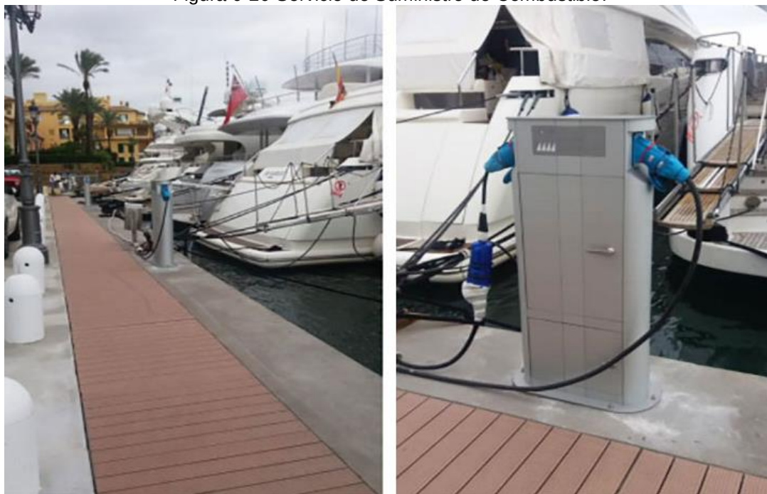
Figura 0-20 Servicio de Suministro de Combustible.
