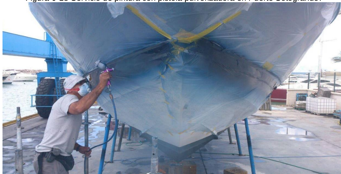
Figura 0-18 Servicio de pintura con pistola pulverizadora en Puerto Sotogrande.
