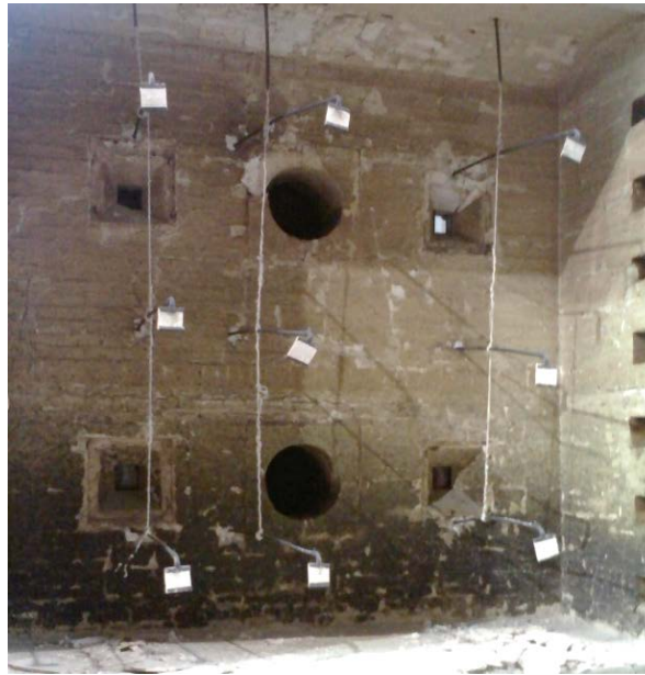
Fig. 67. Interior del horno de ensayos.
