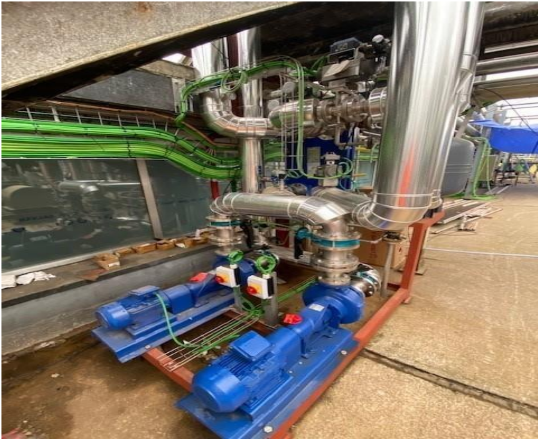
Ilustración 2 "Circuito real Intercambiador de Calor" Fuente propia
