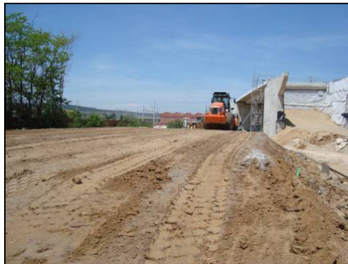
Figura 4.39: Compactación de la segunda capa del terraplén de suelo-escoria, con rodillo liso vibratorio.
