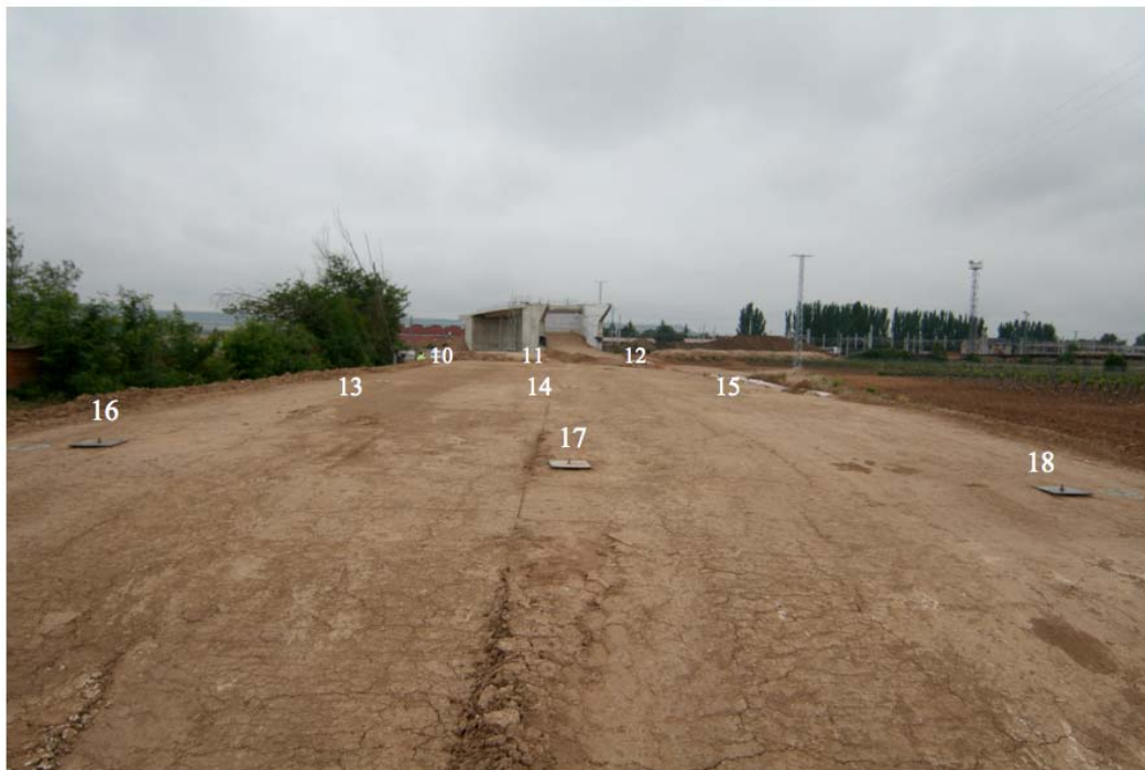
Figura 4.65: Distribución de los puntos de control de hinchamiento del terraplén de suelo-cal.
