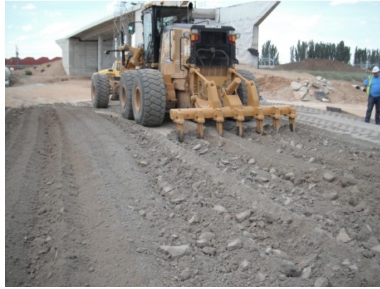
Figura 4.38: Escarificado de una capa de suelo-escoria después de la ejecución de la mezcla.
