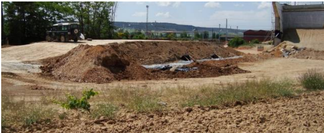
Figura 4.43: Vista general del terraplén de suelo-escoria.
