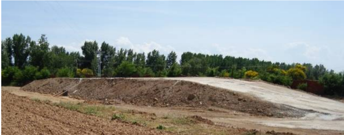
Figura 4.42: Vista general del terraplén de suelo-cal.
