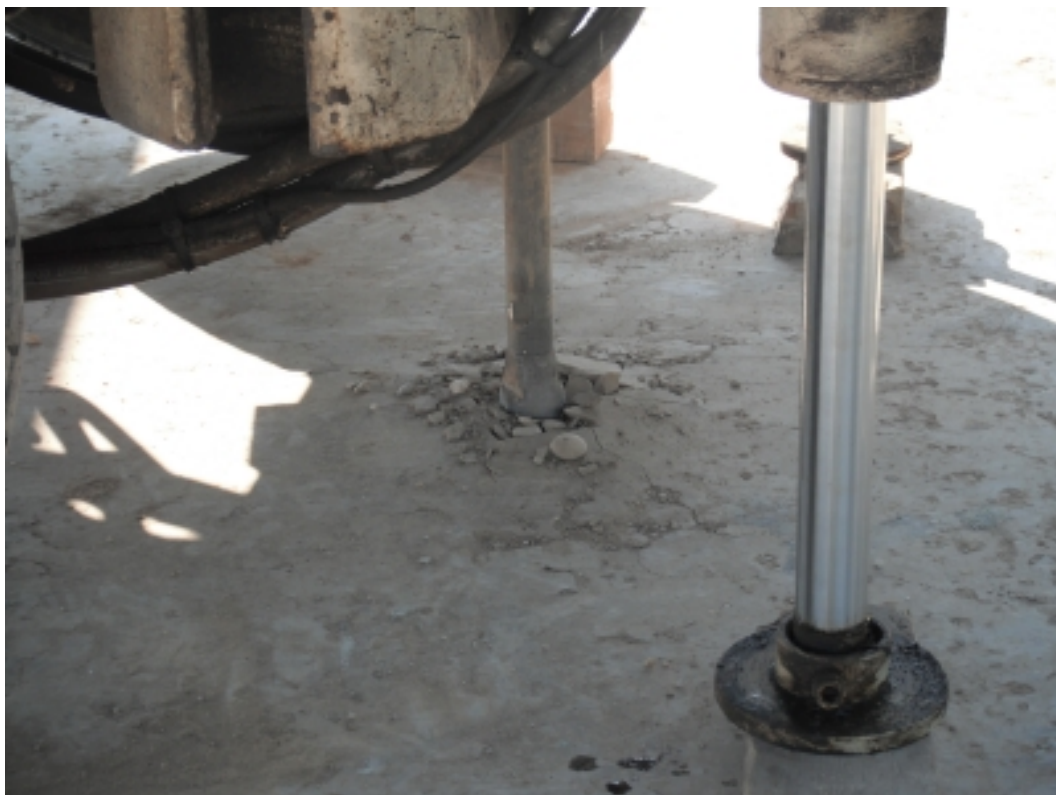
Figura 4.60: Penetración de los primeros centímetros de la puntaza cónica en la coronación del terraplén de suelo-escoria.
