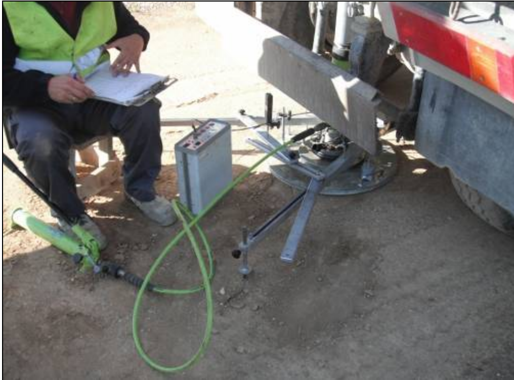
Figura 4.46: Ensayo de placa de carga efectuado sobre la cimentación del terraplén suelo-cal.
