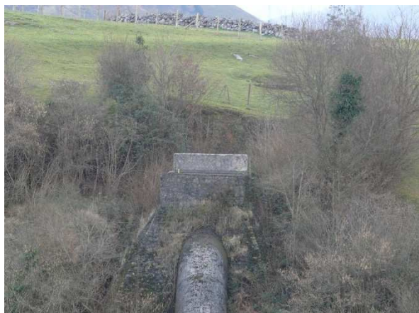
Cámara de entrada
