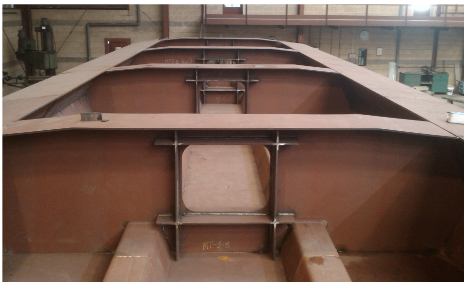
FIGURA 4.5 Diafragma de alma llena en Viaducto de Escaleritas Cortesía de O. R. Ramos
