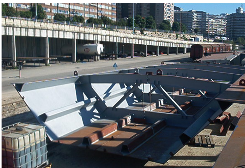
FIGURA 1.1 Viaducto de acceso al Puerto de Vigo Cortesía de Óscar Ramón Ramos
