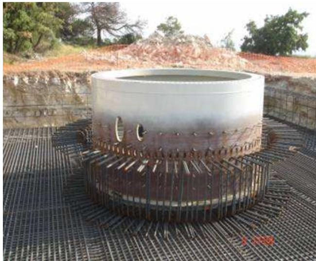
En el pedestal se dispondrán los pernos de anclaje, atornillados a la torre mediante un a brida interior, de forma que transmitan los esfuerzos de la torre a la zapata.
