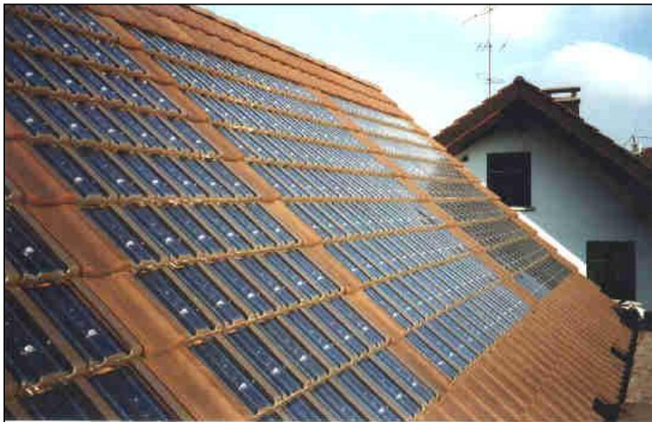
Figura 3.12. Tejas Fotovoltaicas
