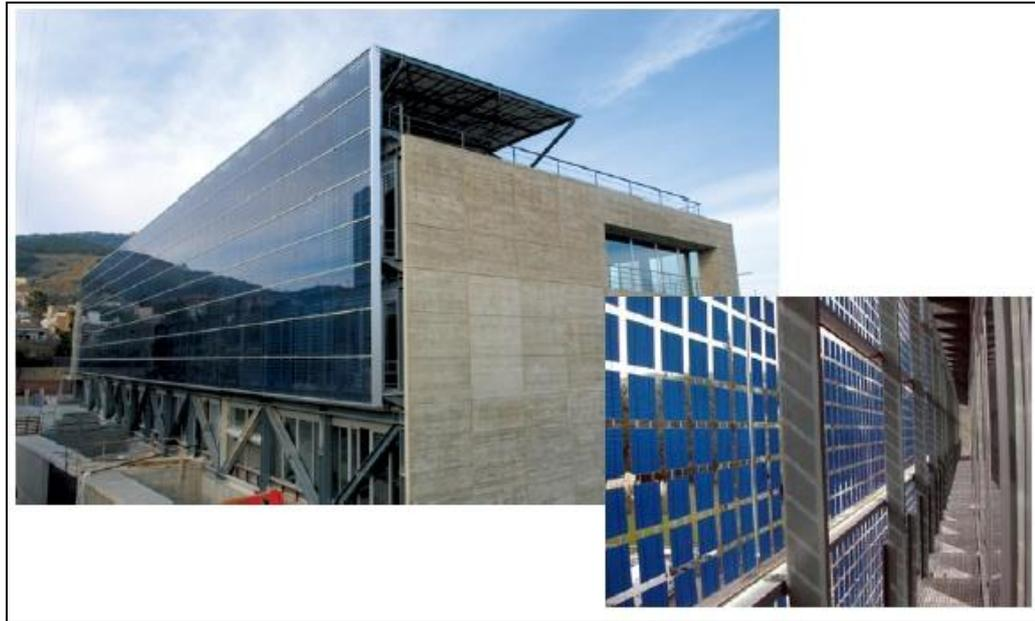
Fig. 3.11.- Integrado-Cerramiento: fachada semi-transparente
