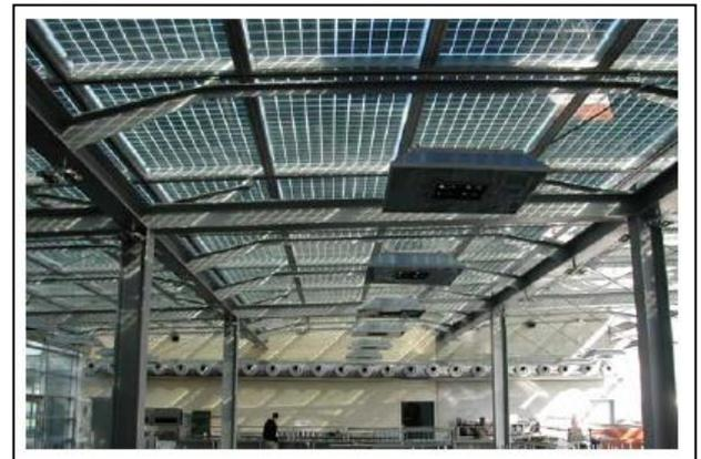
Fig. 3.10.- Integrado: Cubierta
