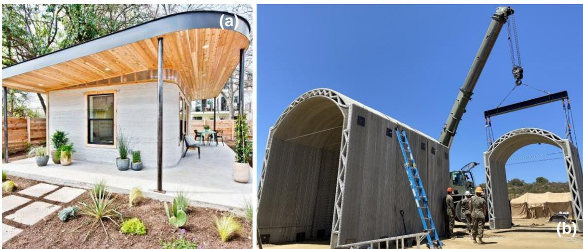
Figura 2-5. ICON: (a) Prototipo de vivienda impreso en 3D. Fuente: [52]. (b) Búnker impreso en 3D y montaje. Fuente: [53].
