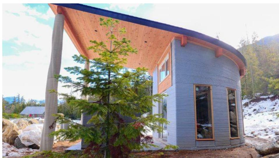
Figura 2-10. TAM: Casa modular impresa en obrador y montada insitu. Fuente: [60].
