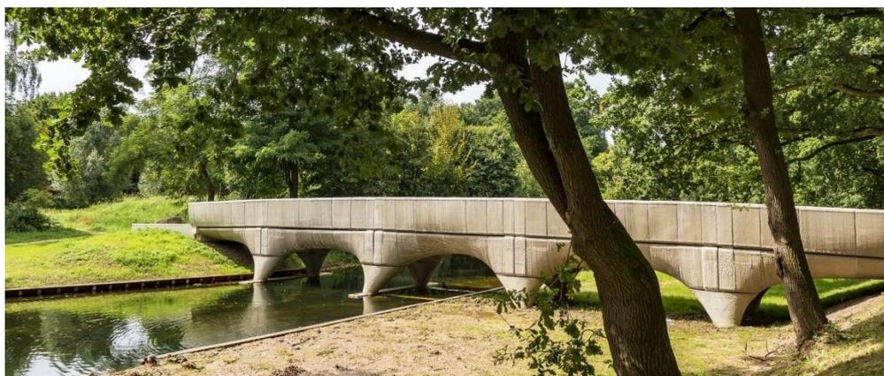
Figura 2-11. BAM: Puente peatonal de 29 m de longitud impreso en 3D. Fuente: [61].
