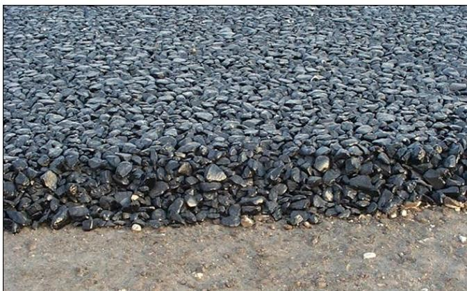
*Ilustración 7.* Perfil de aglomerado asfáltico con tejas recicladas.
