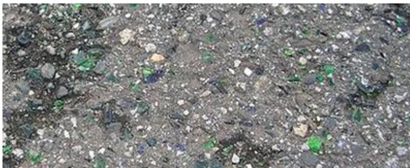
**Ilustración 23.** Imagen de capa superficial de asfalto con vidrio reciclado.
