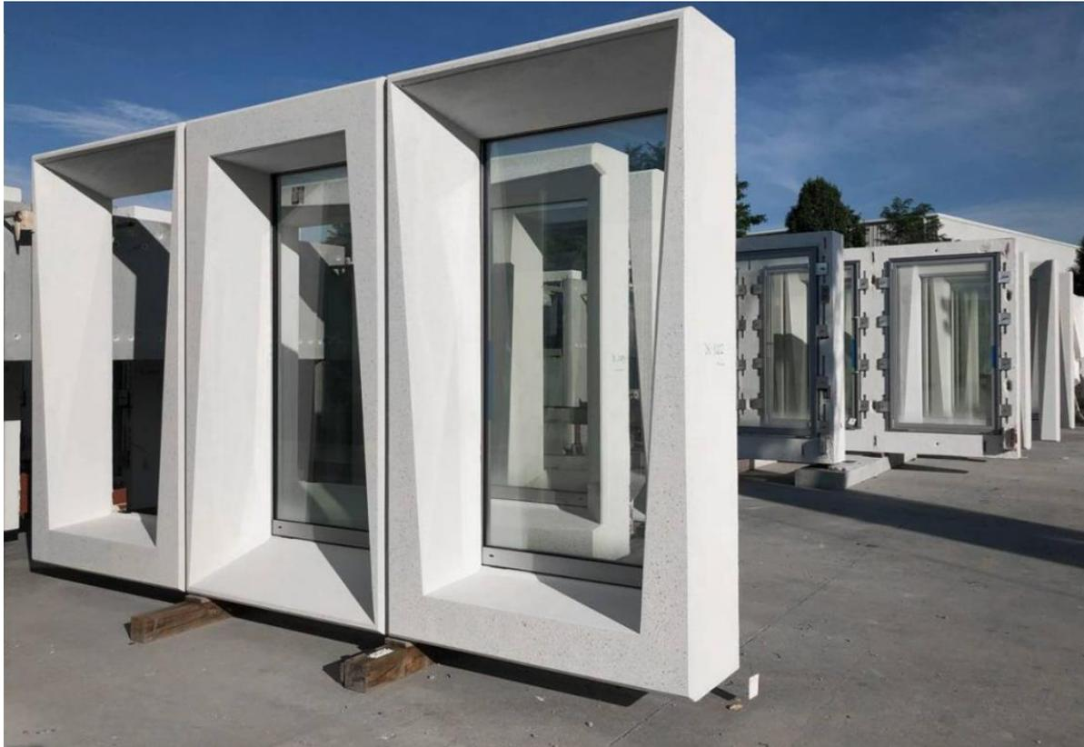
*Figura 16: Ventanas prefabricadas construidas con moldes hechos mediante impresión 3D. (Redshift ES. , 2019)*
