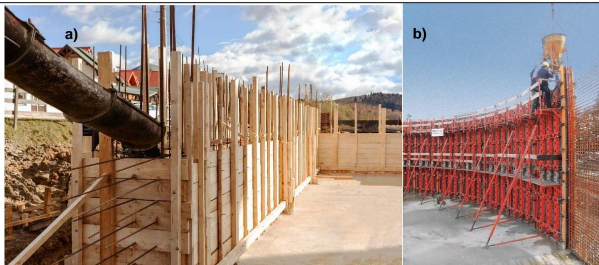
Figura 13: Encofrados sobre los que está realizando el vertido del hormigón. a) Encofrado de madera. (Freepik., 2021), b) Encofrado de metal. (Equiposdetrabajoenaltura, 2019)
