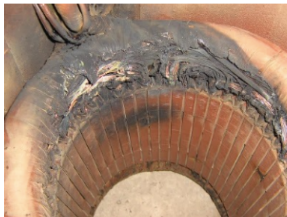
Figura 2: Devanado defectuoso del estátor en un alternador y bobinas quemadas en la conexión (Texas Instruments [5])
