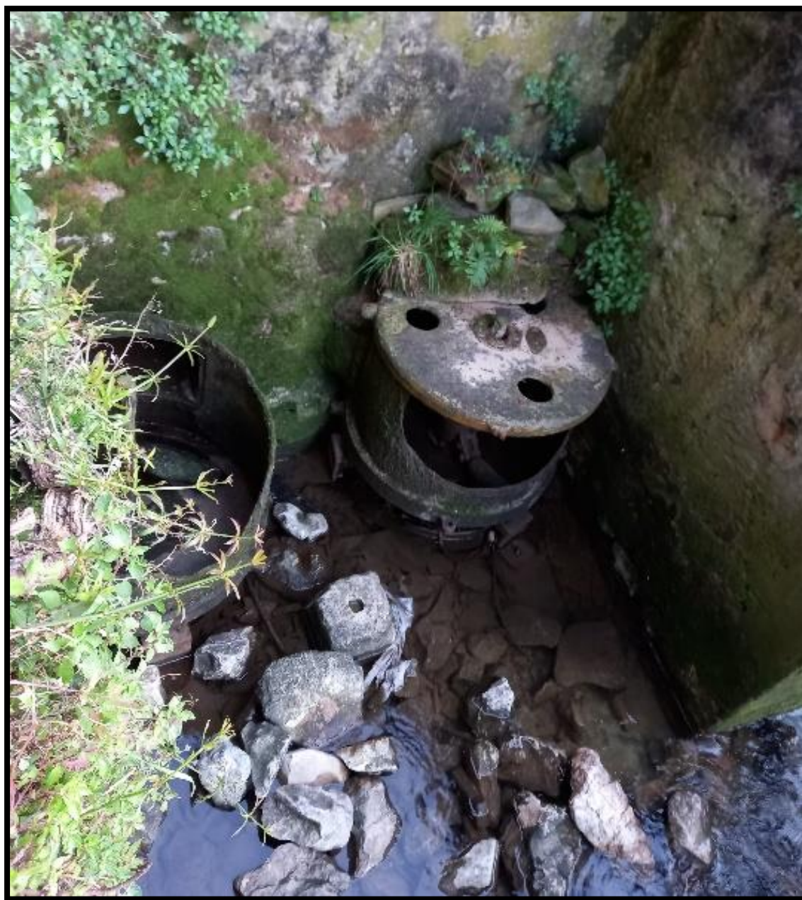
Imagen 14: Elementos internos del molino 122 .
