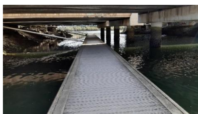
Puente de conexión entre las Marismas Blancas-Marismas Negras
