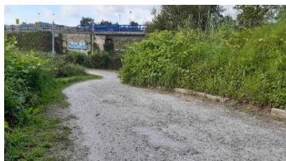
Desnivel en las Marismas Negras
