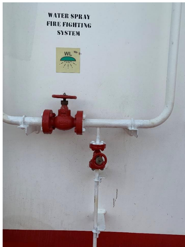
Ilustración 43 Sistema del pañol de pintura.
