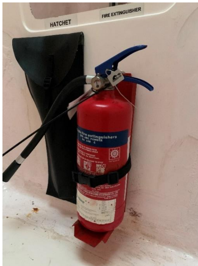
Ilustración 12 Colocación del extintor.
