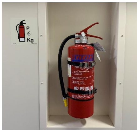
Ilustración 11 Colocación del extintor.
