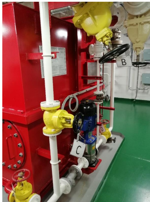
Ilustración 37 Mecanismo para el funcionamiento del sistema de baja expansión.
