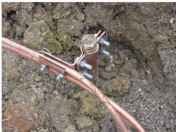
*Figura 19. Mejora de la puesta a tierra en anillo mediante pica (electrodo) conectada al conductor de cobre*
