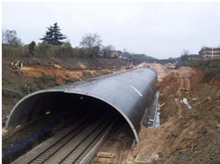
*Ilustración 5.4: Construcción del túnel Guerrads Cross, Inglaterra, por el método “cut and cover”.
