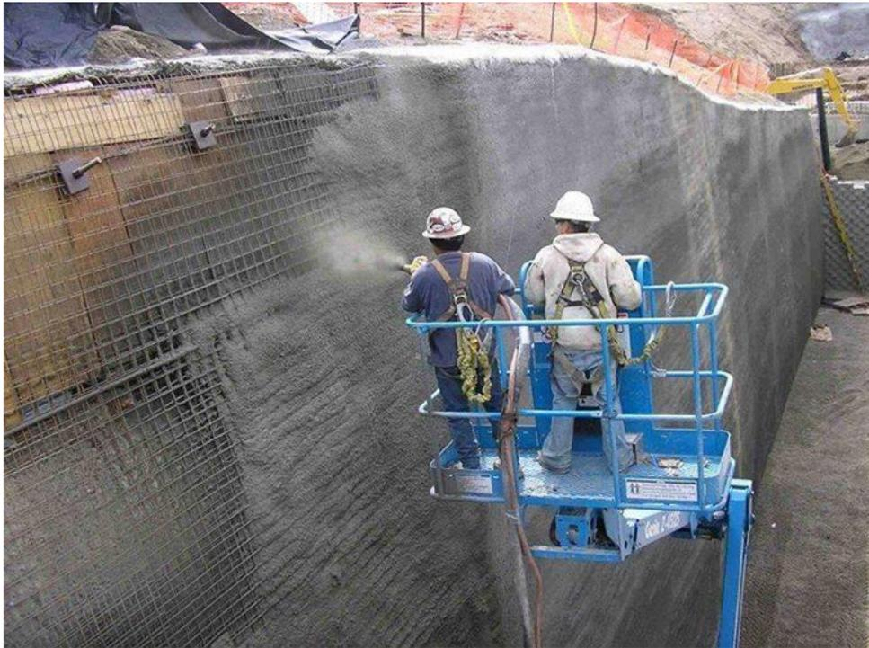
*Ilustración 6.14: Hormigón proyectado reforzado con malla electrosoldada. Fuente: Yepes Piqueras, 2017.*
