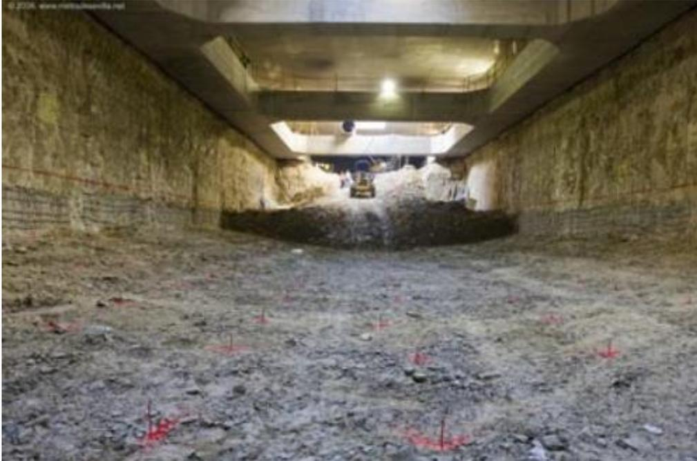
*Ilustración 5.6: Puesta en obra del método "top down". Fuente: Yepes Piqueras, 2015.*
