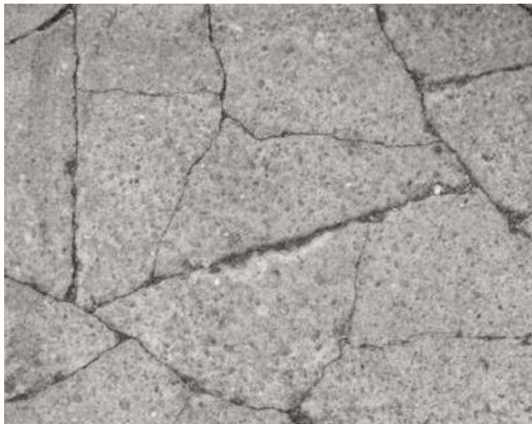
*Ilustración 8.3: Resultado de la restricción sobre el hormigón. Fuente: Isostatika, 2021.*
