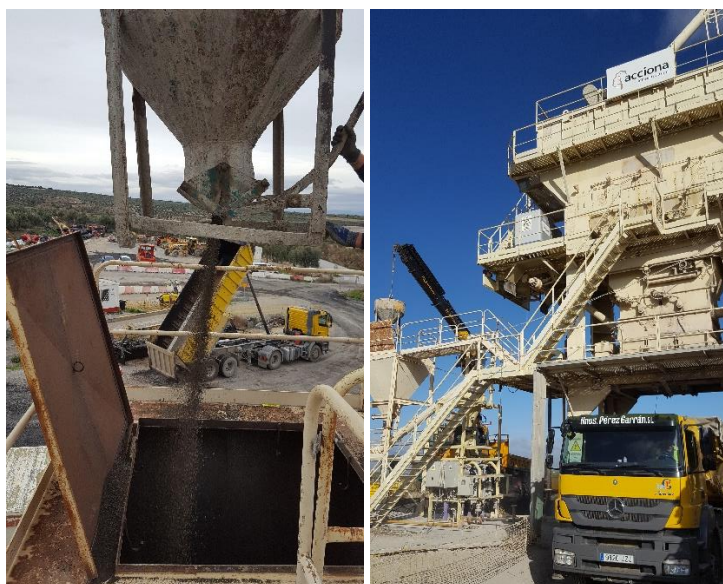
Figura 71. Fotografías tomadas de la planta asfáltica donde se ve el dosificador de aditivos sólidos
