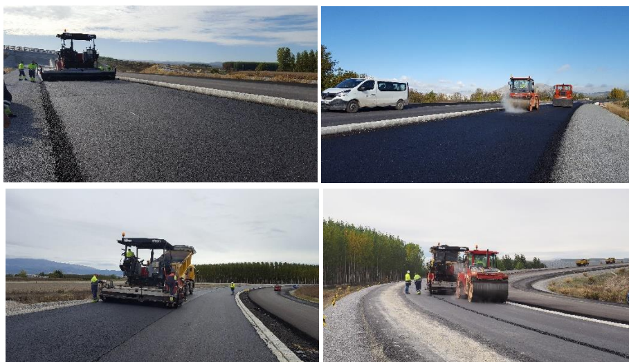
Figura 72. Fotos de la puesta en obra del tramo de prueba: extendido, compactación mezcla AC22binS (arriba) y AC16SurfS (abajo)
