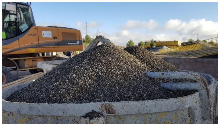
Figura 70. Detalle de las cápsulas preparadas en los cubilotes para su descarga en el dosificador
