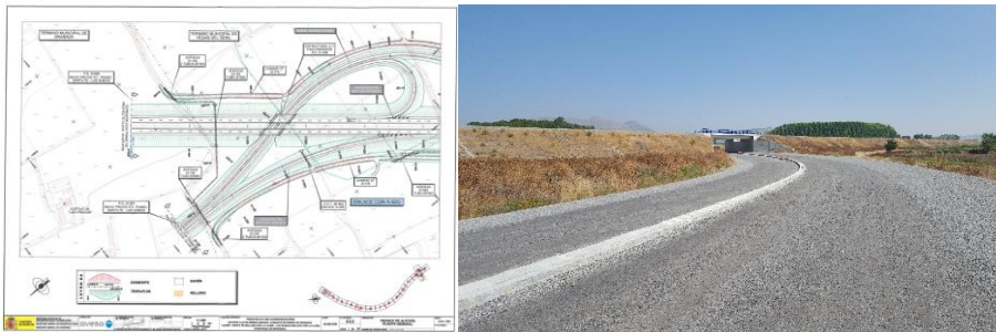
Figura 27. Localización del tramo de prueba en un ramal de la obra A-44: Enlace Santa Fé-Las Gabias
