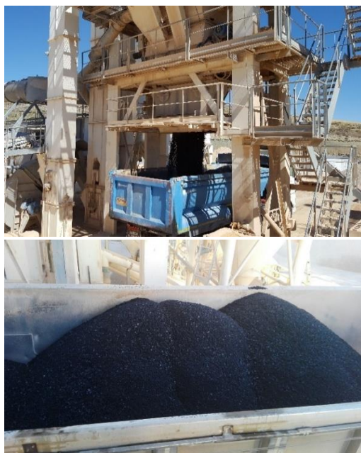
Figura 39. Fotos durante la etapa de fabricación de la mezcla asfáltica
