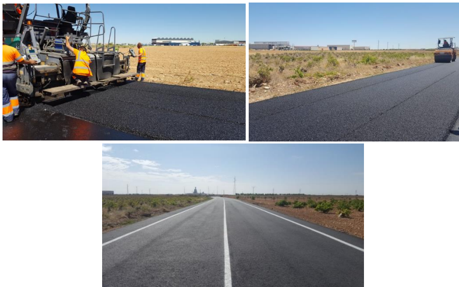
Figura 40. Fotos de la puesta en obra del tramo de prueba (extendido, compactación y vista final).
