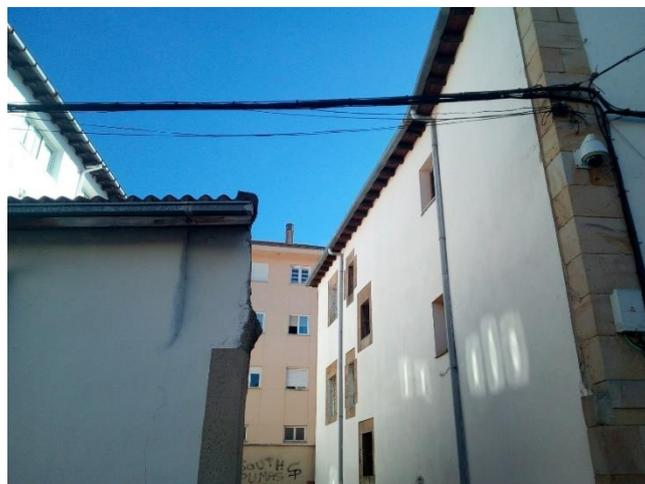
*Figura 61. Tendido del cableado en fachadas*
