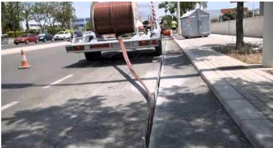
*Figura 60. Preparación de una microzanja en la calle*
