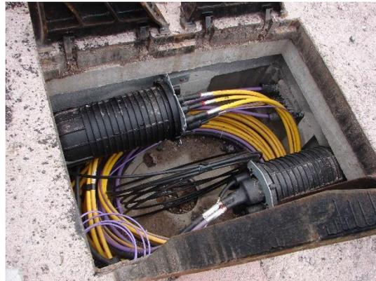
*Figura 64. Arqueta para la red de cableado*
