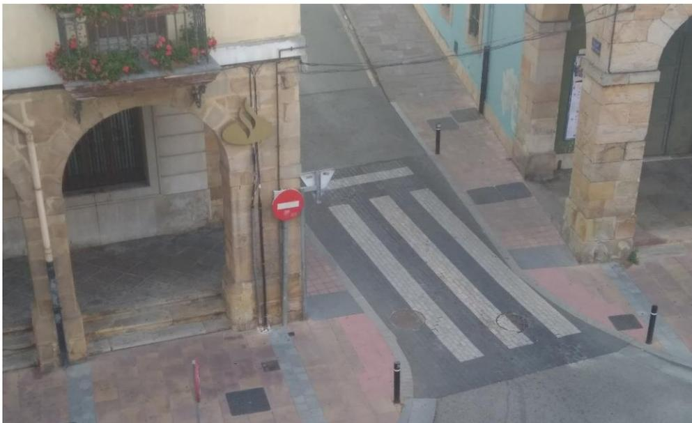
*Figura 65. Tendido de red donde desde la arqueta se lleva el tendido hasta la señal de prohibido el paso, y desde ahí se sube dentro de un tubo hasta tener una altura fuera de peligro y se lleva por fachada*
