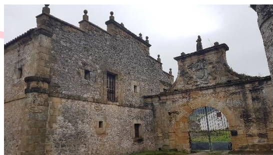
Ilustración 10. Casona de Torre-Herrera
